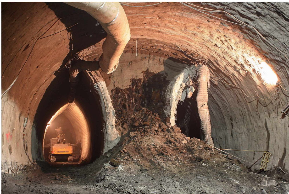
Výstavba ražené části tunelu (2011, foto archiv autora)
