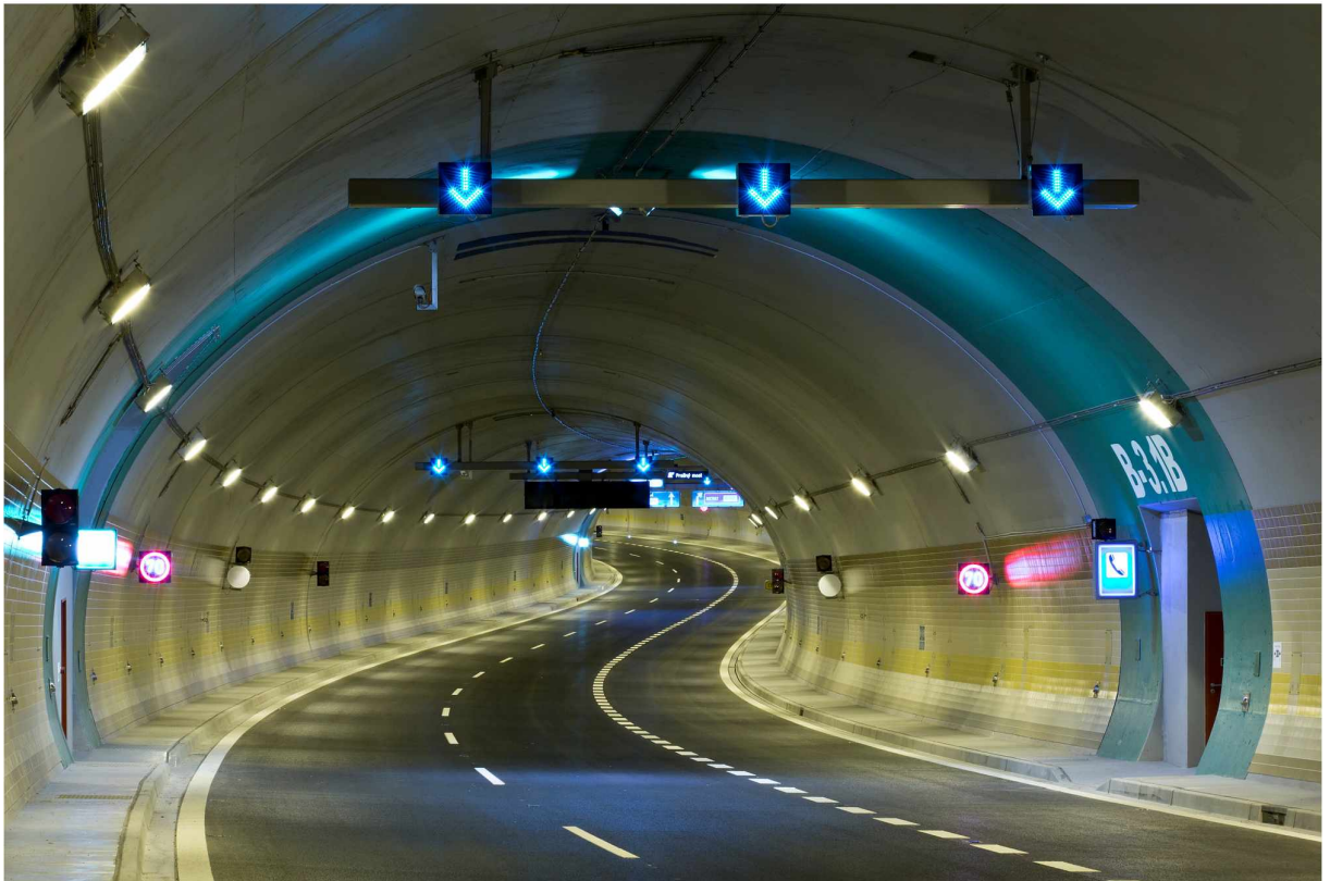
Dopravní prostor třípruhového tunelu (2015, foto archiv autora)
