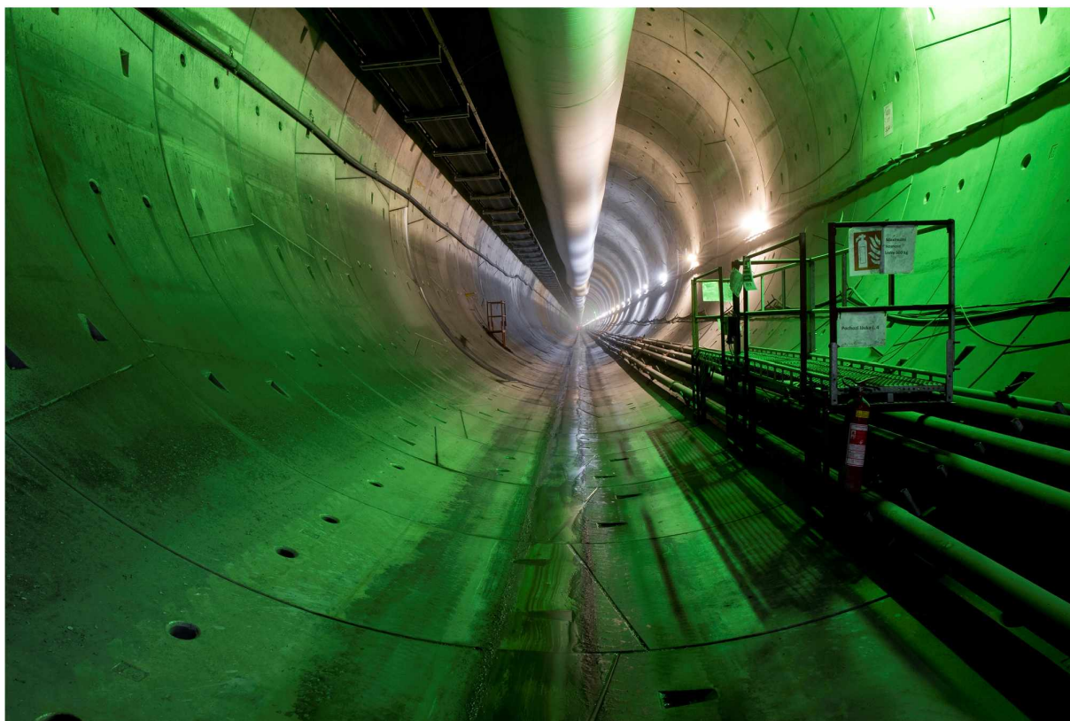
Výstavba ražené části tunelu (2015, foto archiv autora)
