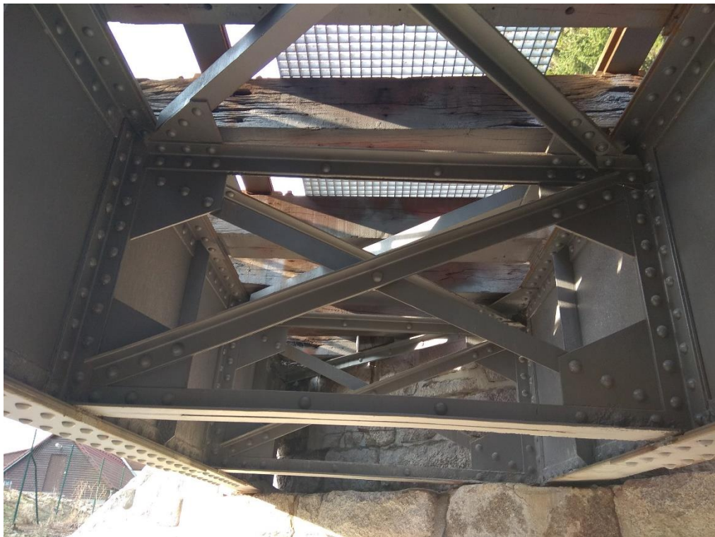
Obrázek 10 – Detail příčného vyztužení mostní konstrukce
