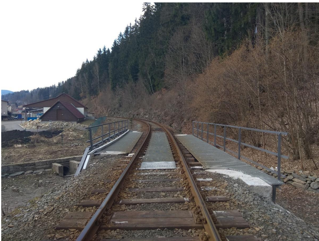
Obrázek 7 – Pohled na mostní konstrukci z železničního svršku ve směru Jablonec nad Jizerou
