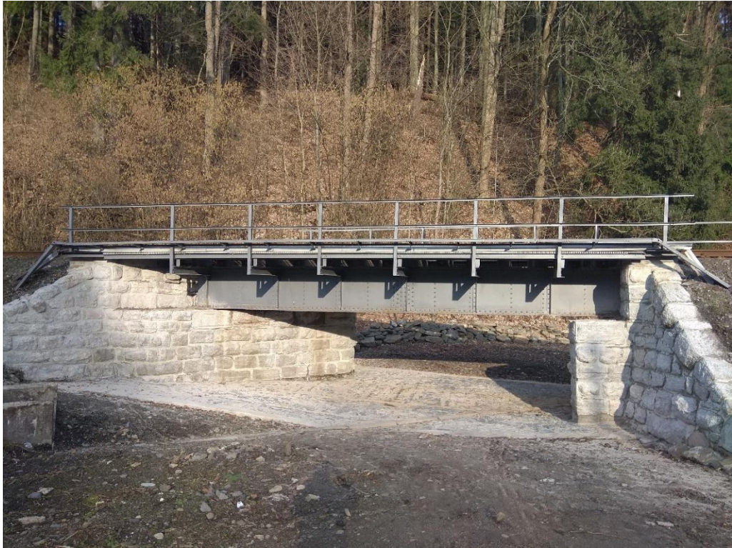
Obrázek 4 – Pohled na mostní konstrukci z PK od Jablonce nad Jizerou
