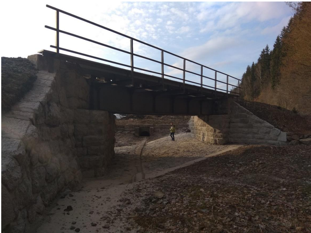
Obrázek 5 – Pohled na mostní konstrukci od Poniklé
