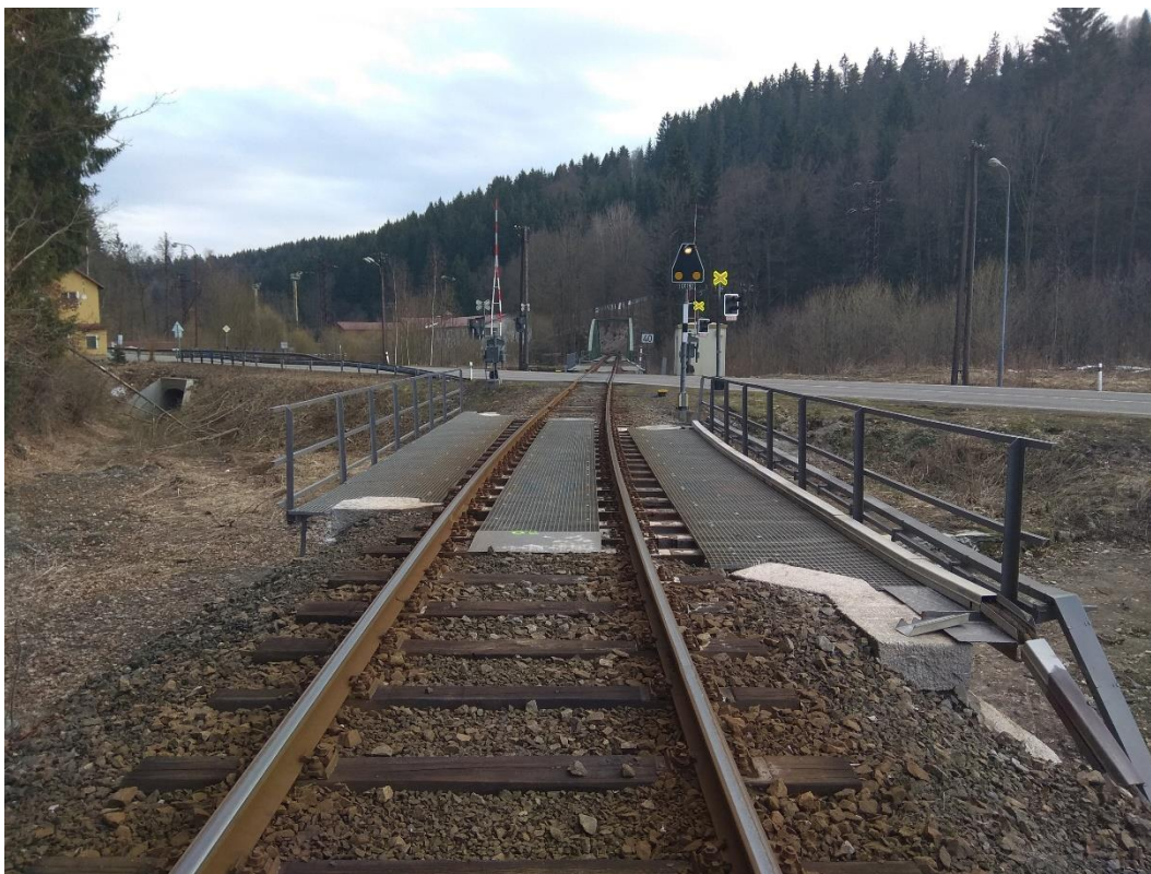
Obrázek 6 – Pohled na mostní konstrukci z železničního svršku ve směru Poniklá
