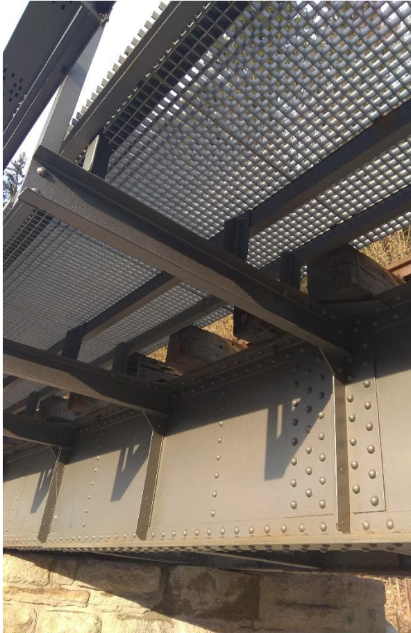
Obrázek 8 – Detail vykonzolování chodníkové části mostní konstrukce
