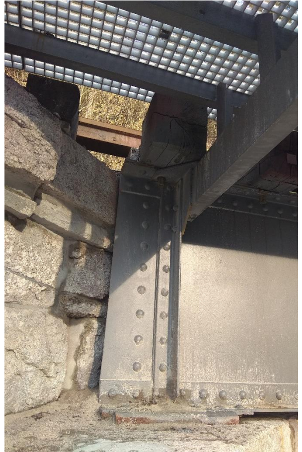
Obrázek 9 – Detail uložení mostní konstrukce
