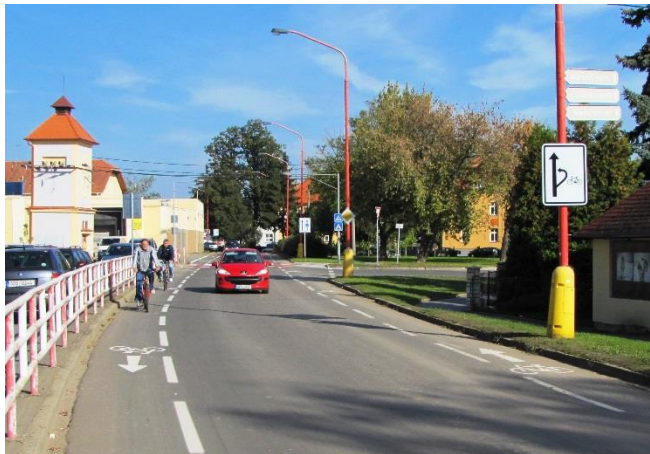
Obrázek 3 Víceúčelový jízdní pruh v Uherském Hradišti. Zdroj www.cyklodoprava.cz
