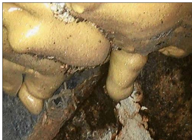
Obr. 10: Endoskopický průzkum – defekt laminátu opravený PU pěnou, zásah z roku 2001, snímek z roku 2015 (foto M. Tkáč).
