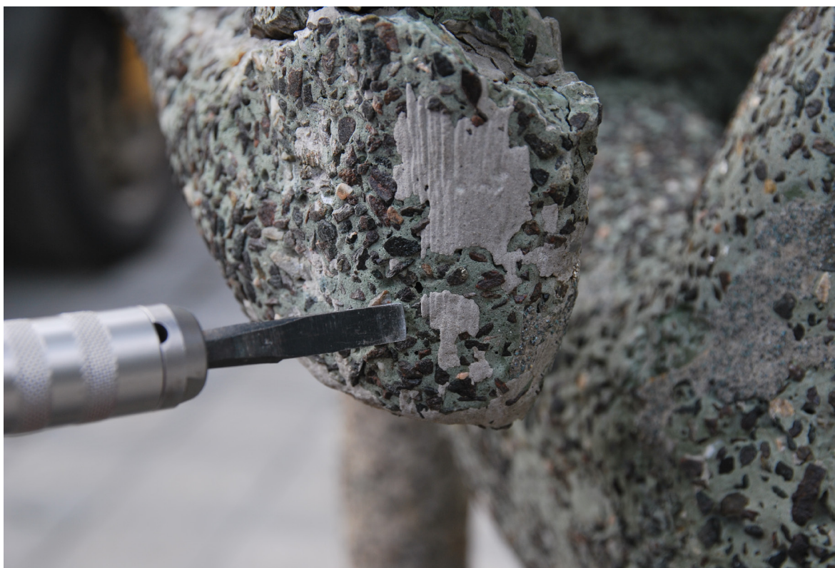
Mechanické odstraňování nevhodného cementového šlemu
