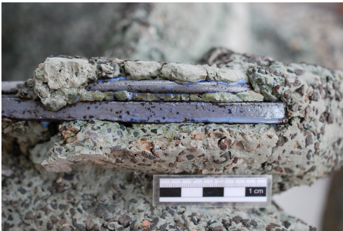
Antikorozní ochrana obnažené výztuže
