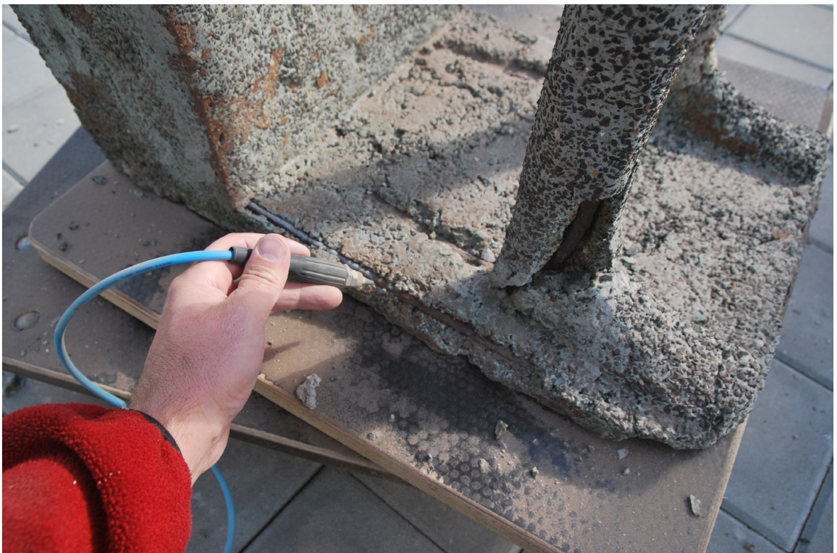
Obnažená výztuž v průběhu tryskání
