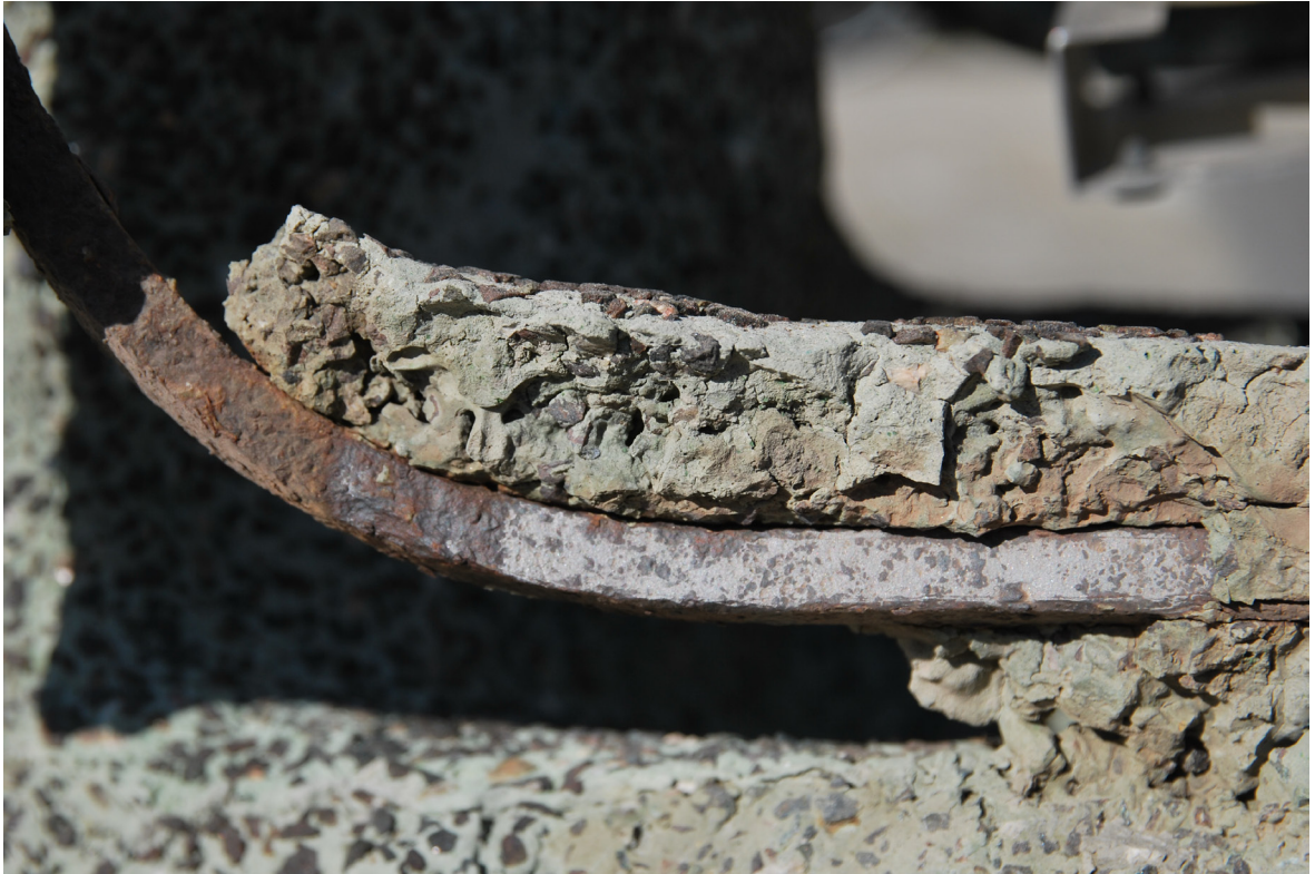
Obnažená výztuž v průběhu tryskání
