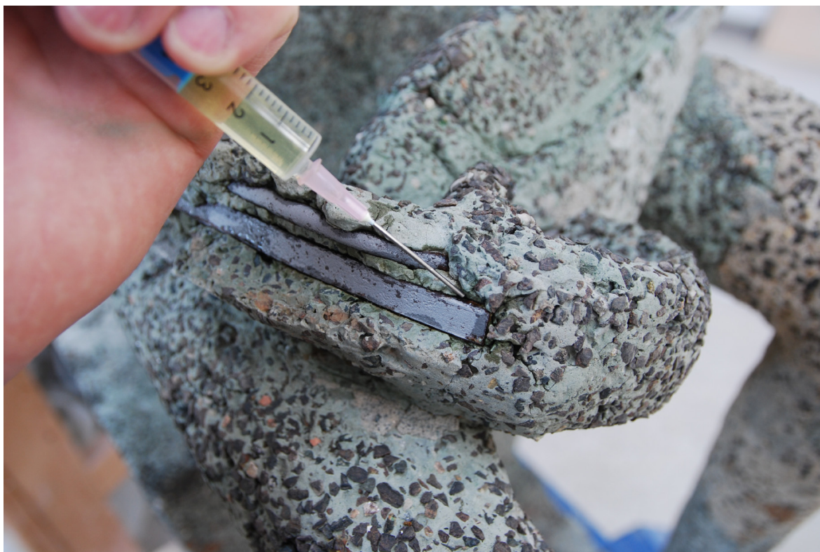
Pasivace nevyproštěných částí výztuže
