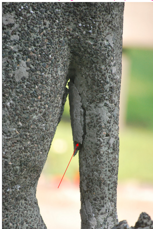
Odpadlý kus betonu v podpaží sochy
