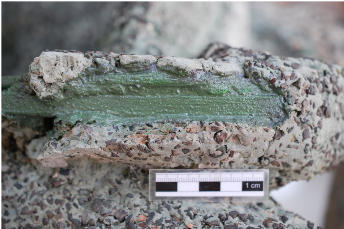
Ve hmotě probarvený adhezni můstek na ošetřenou výztuž
