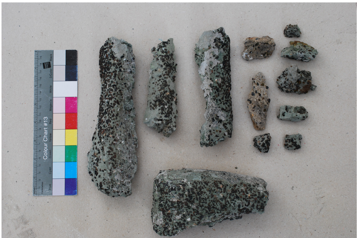
Uvolněné prvky snesené za účelem obnažení výztuže a jejich následovného přilepení
