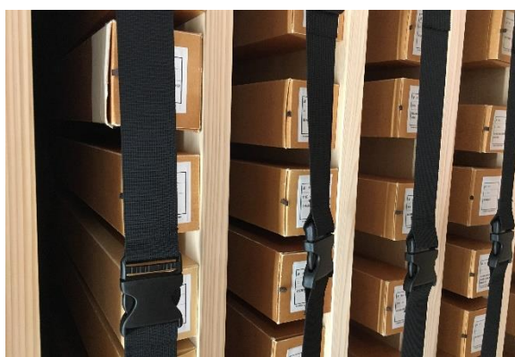
Obr. 26 Alternativa uložení svitku v Prefekturní Knihovně v Kjótu, zajištěné ochrannými pasy proti zemětřesení.
