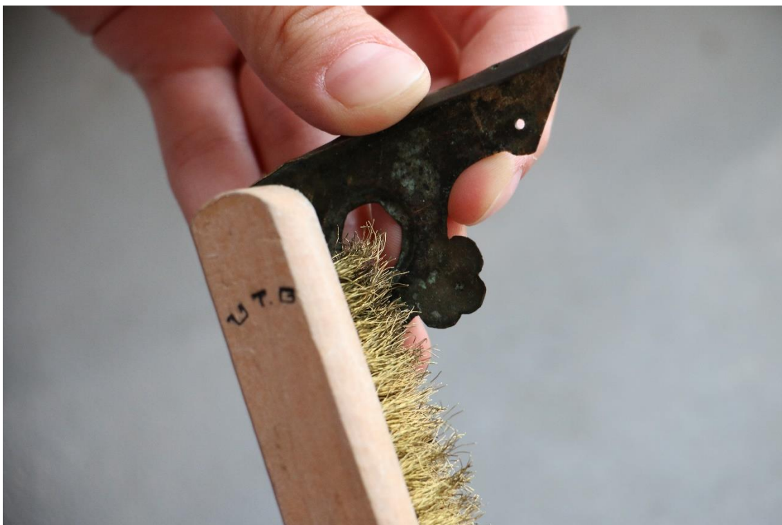
Fotografie č. 80 Čištění nárožnice pomocí mosazného kartáčku
