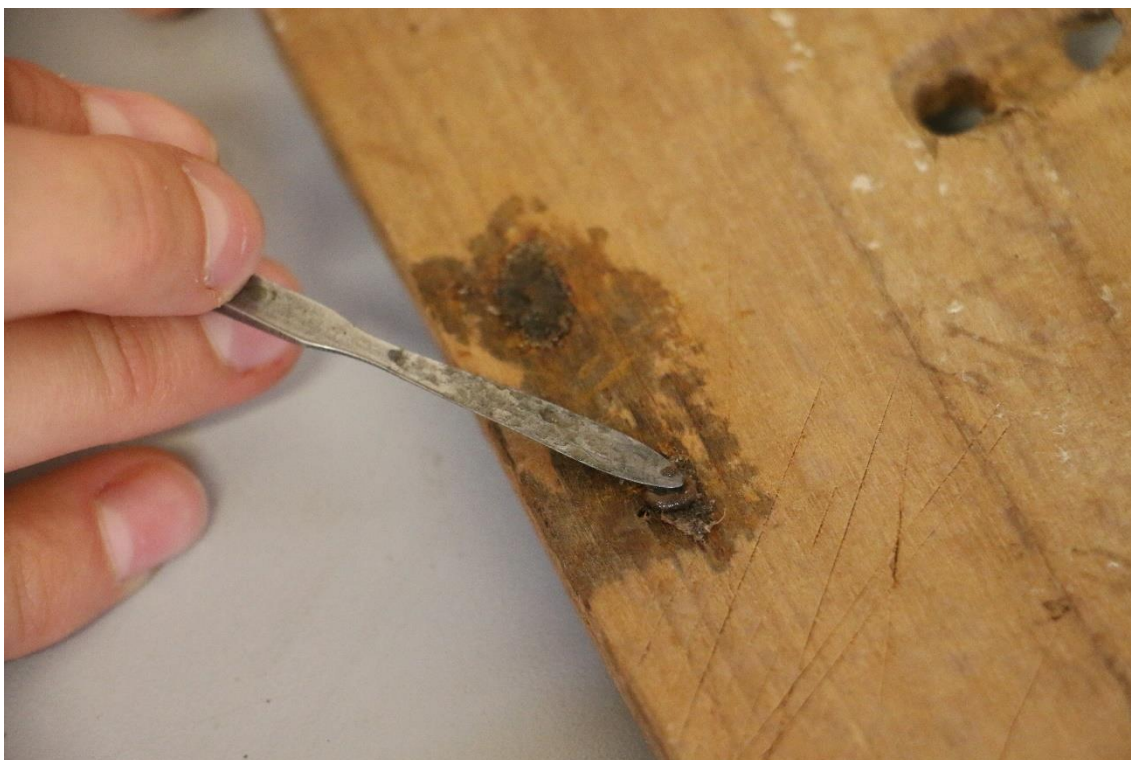
Fotografie č. 63 Tmelení otvoru v desce
