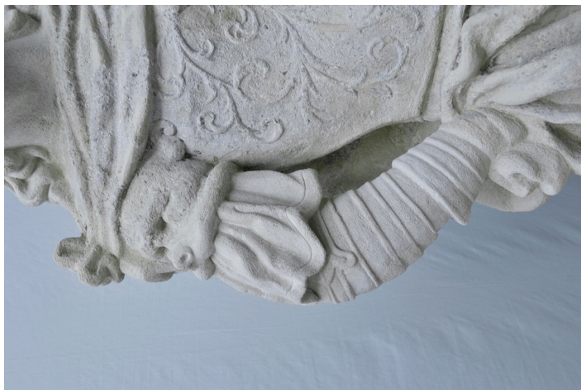
Obrázek 45 Detail ruky po osazení a vytmelení
