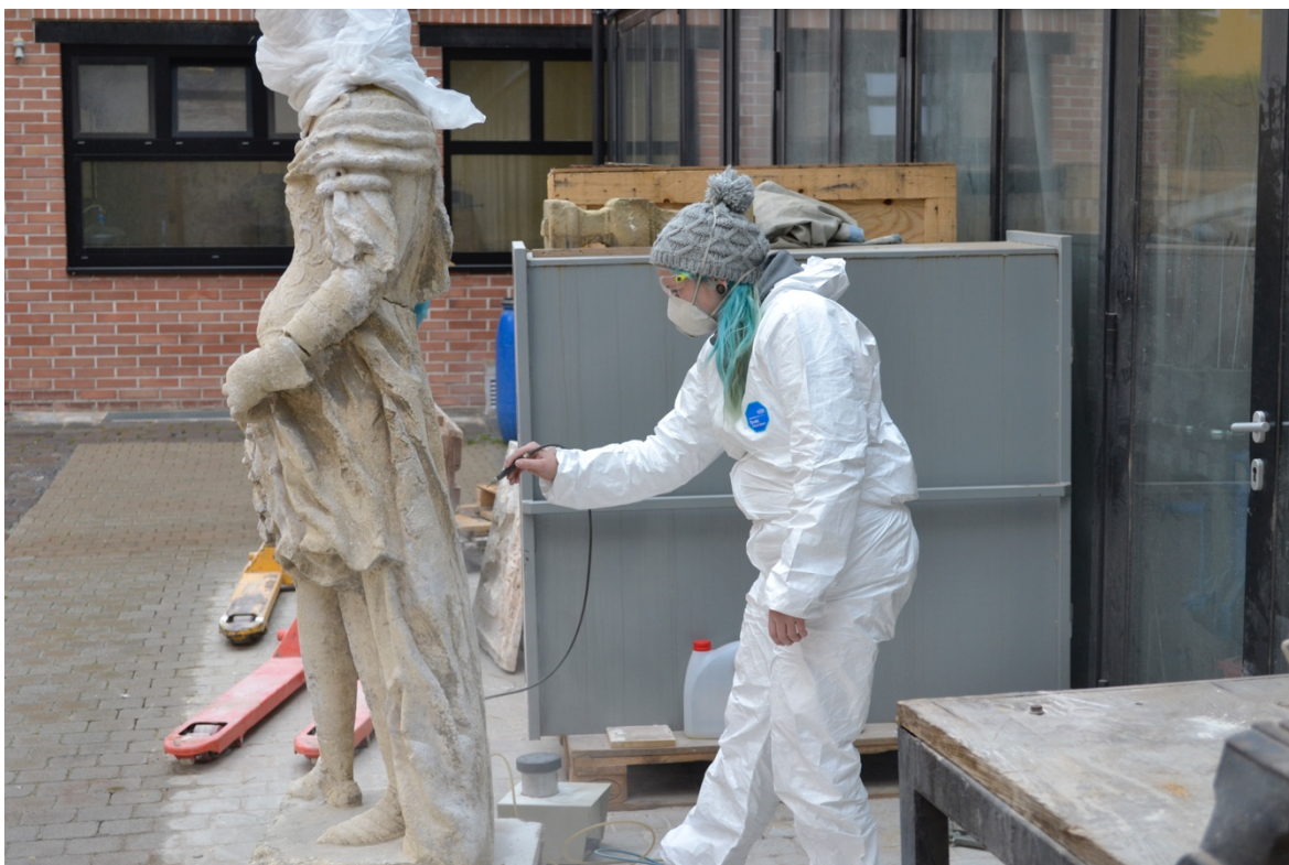
Obrázek 57 Čištění povrchu metodou abrazivního pískování
