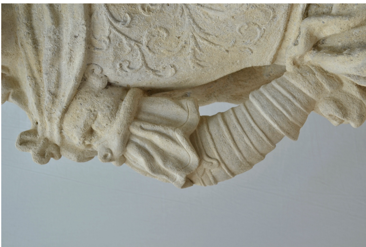
Obrázek 65 Detail nového doplňku ruky z umělého kamene
