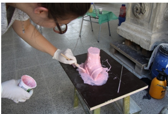
Obr. 62 Zaformování doplňku pomocí silikonu
