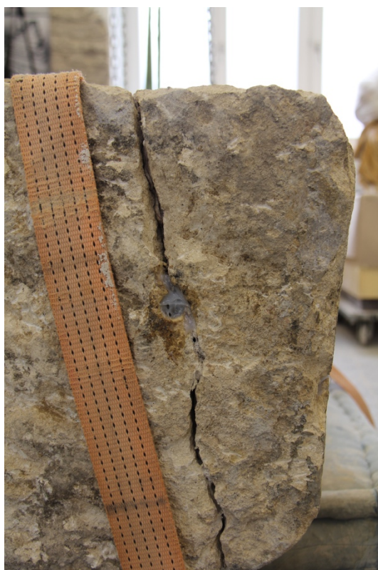
Obr. 72 Lepení nové armatury
