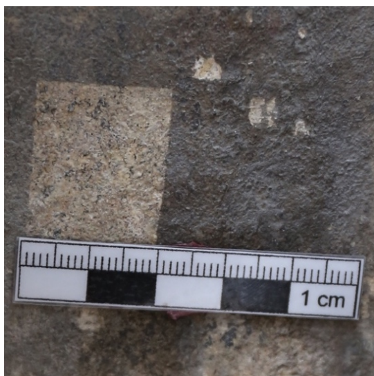
Obr. 27 Plocha k provedení zkoušky čištění pomocí amonné soli EDTA
