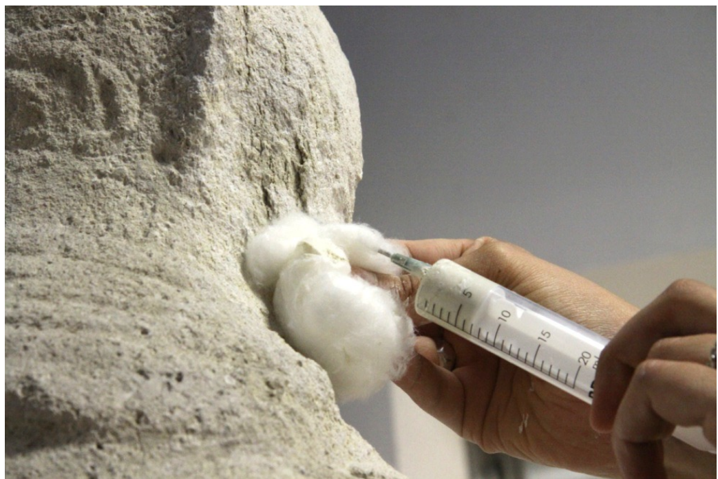
Obr. 75 Injektáž prasklin v kameni
