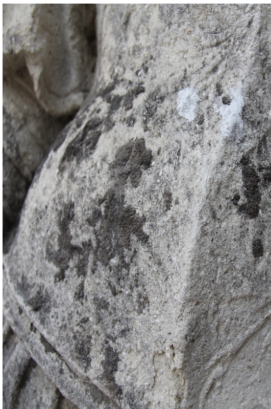
Obr. 91 Stav před restaurováním – jeho pravá strana břicha
