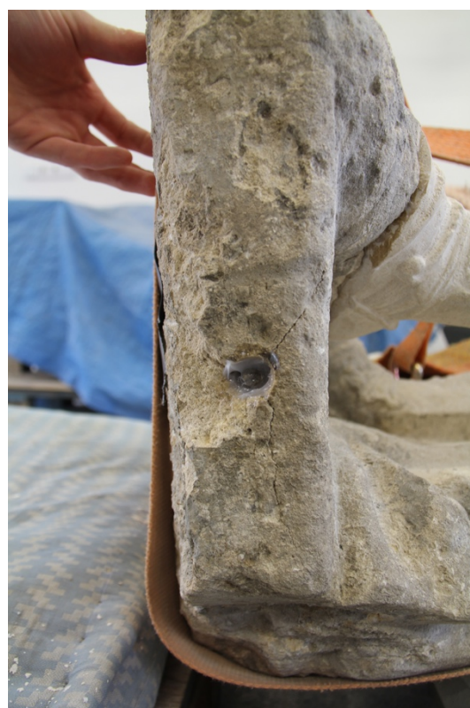
Obr. 73 Lepení nové armatury
