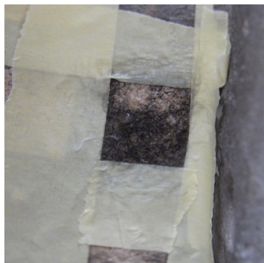
Obr. 28 Částečně očištěná horní část zkoušky po půlhodinovém působení chelatačního činidla
