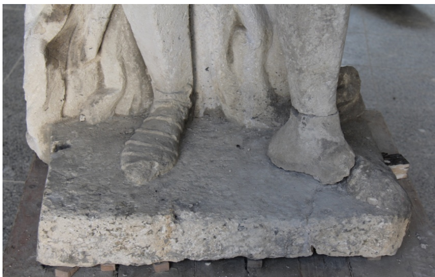
Obr. 66 Detail kotníku po odsekání tmelů
