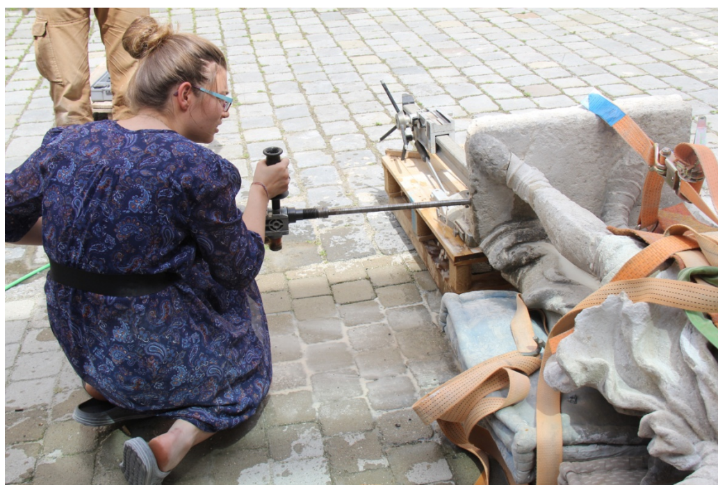
Obr. 71 Vrtání otvorů pro nové kovové armatury pomocí jádrové vrtačky a vody
