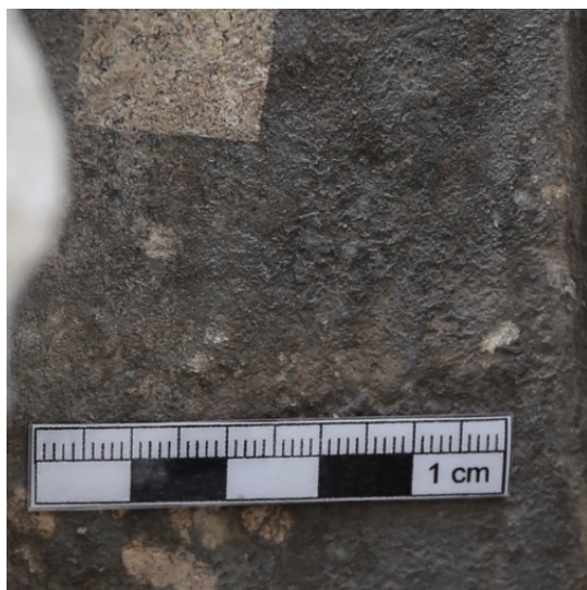
Obr. 24 Detail místa k provedení zkoušky čištění iontoměničem
