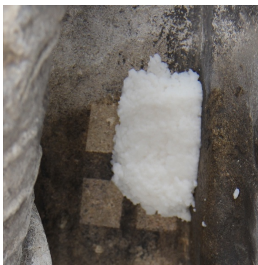
Obr. 33 Vodný zábal z buničiny nanesený na povrch zkušební plochy
