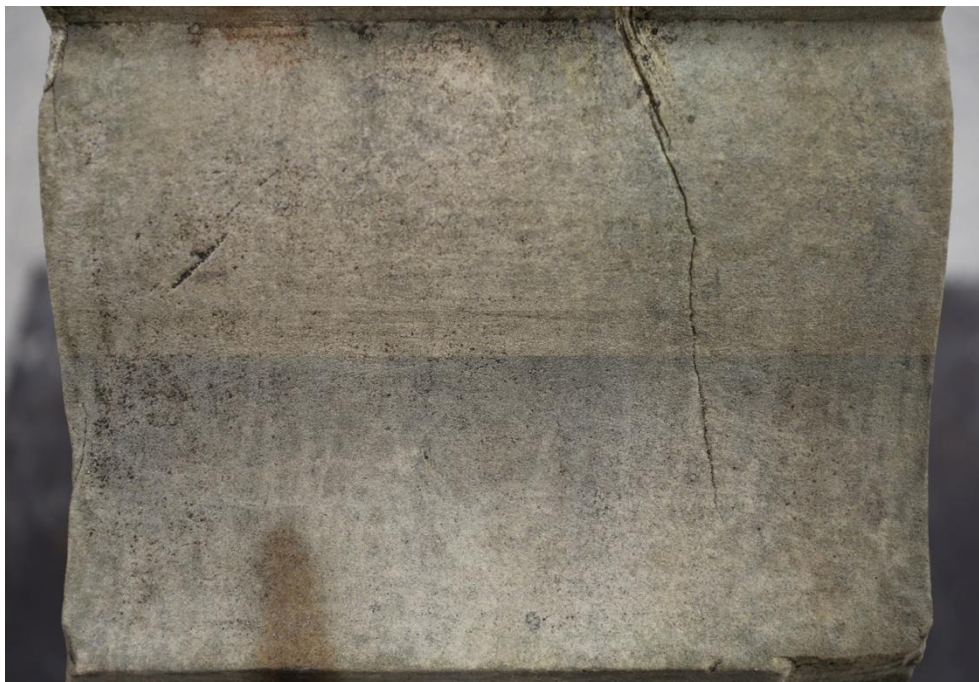
Obrázek 19: Předpřipravená plocha na zkoušky nátěrových hmot, vrchní část očištěna laserem
