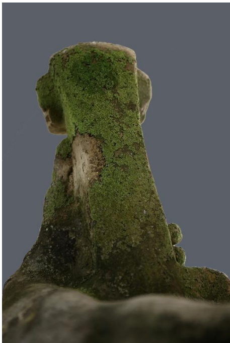
Obrázek 77: Viditelné biologické napadení
