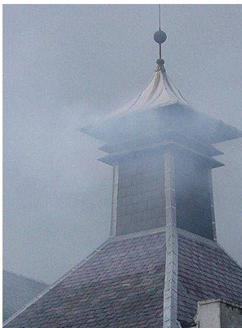
Obrázek 13: Sušírna s pagodovitou střechou [46]
