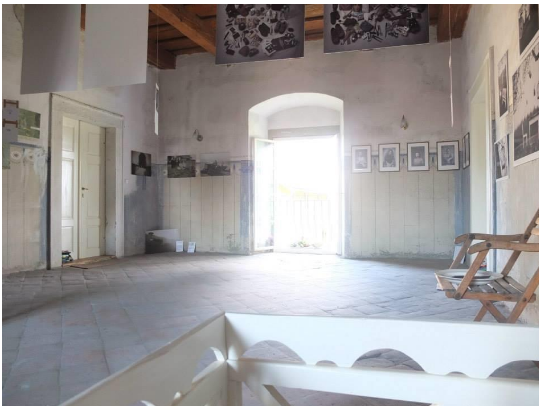
Příloha č. 23: Na podlaze v druhém nadzemním podlaží jsou čtvercové dlaždice, tzv. topinky v diagonálním rastru
