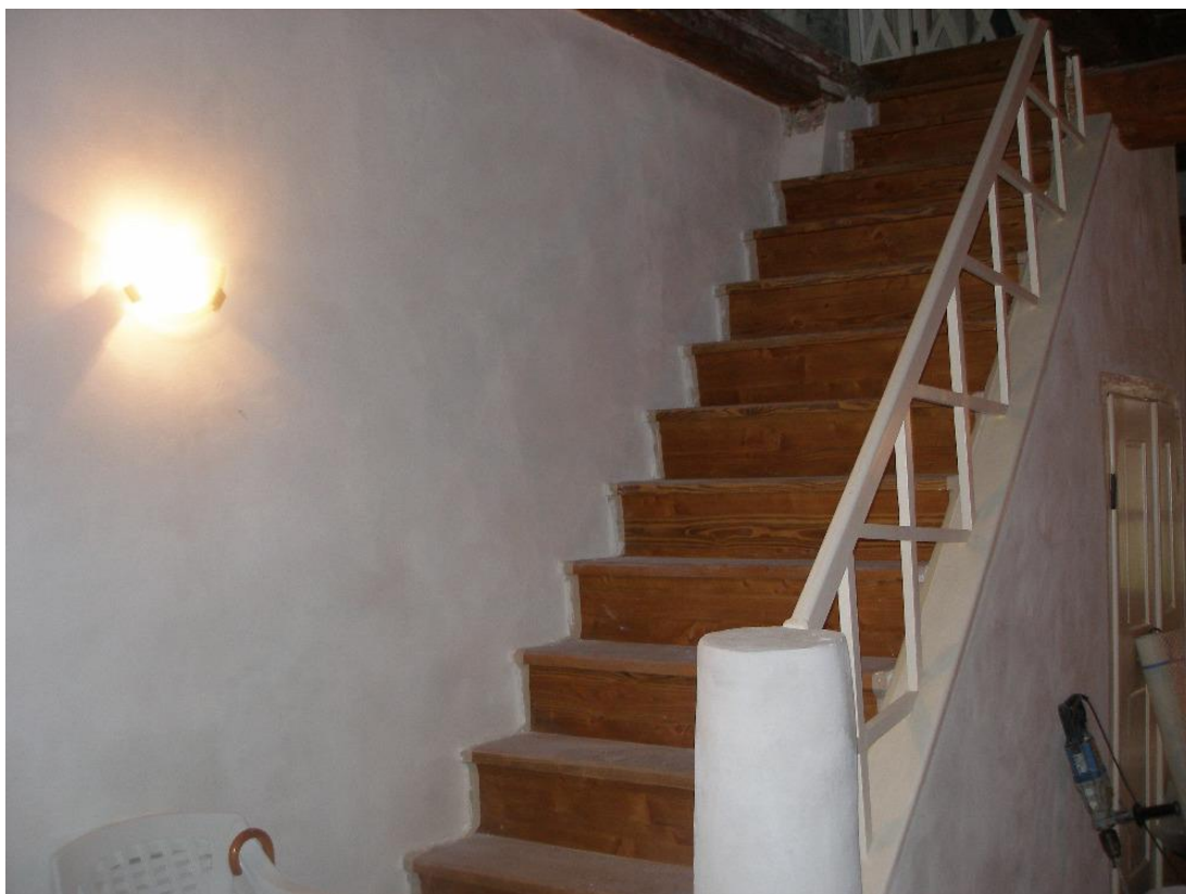
Příloha č. 21: Dřevěné schody vedoucí do druhého nadzemního podlaží
