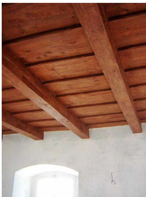
Příloha č. 26: Detail stropu v místnosti druhého nadzemního podlaží
