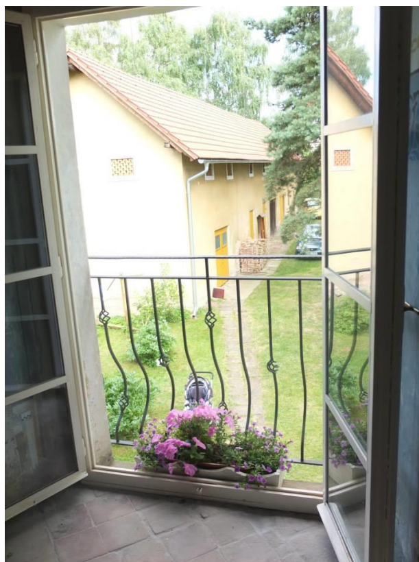
Příloha č. 24: Pohled z francouzského okna, dříve se zde nacházel vstup na balkon
