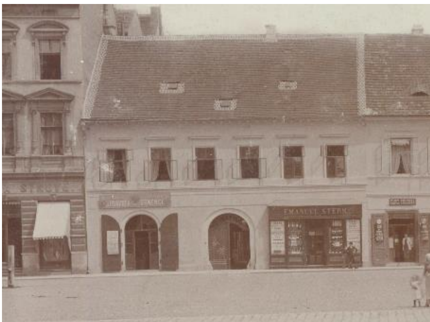
Dům čp. 1461 na fotografii z r. 1894. 328 V patře původní šestice oken, v přízemí patrné původní záklenky vstupů.
