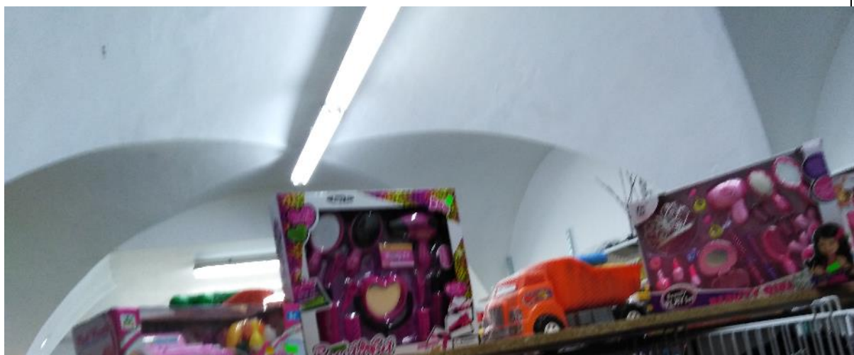
Původní klenby části interiéru domu čp. 498
