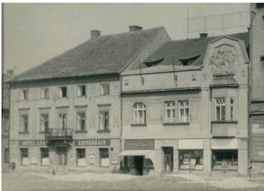
Hotel U Modrého lva a sousední dům (dnes oboje hotel Lev čp. 508), na fotografii M. Petroviče z 50. let 20. stol. Na domu uprostřed patrná prvorepubliková výzdoba, nápadný štít na arkýřem 220
