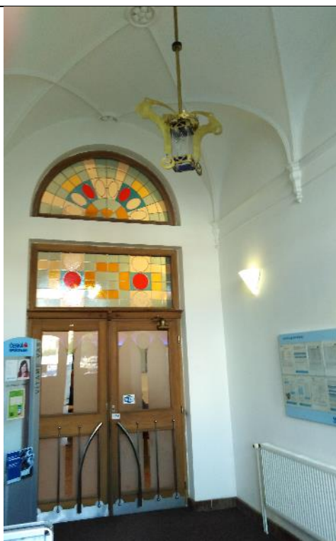
Vstupní chodba domu čp. 507 z náměstí, charakteristické zdobení světlíků dveří a plastické orámování výsečí klenby
