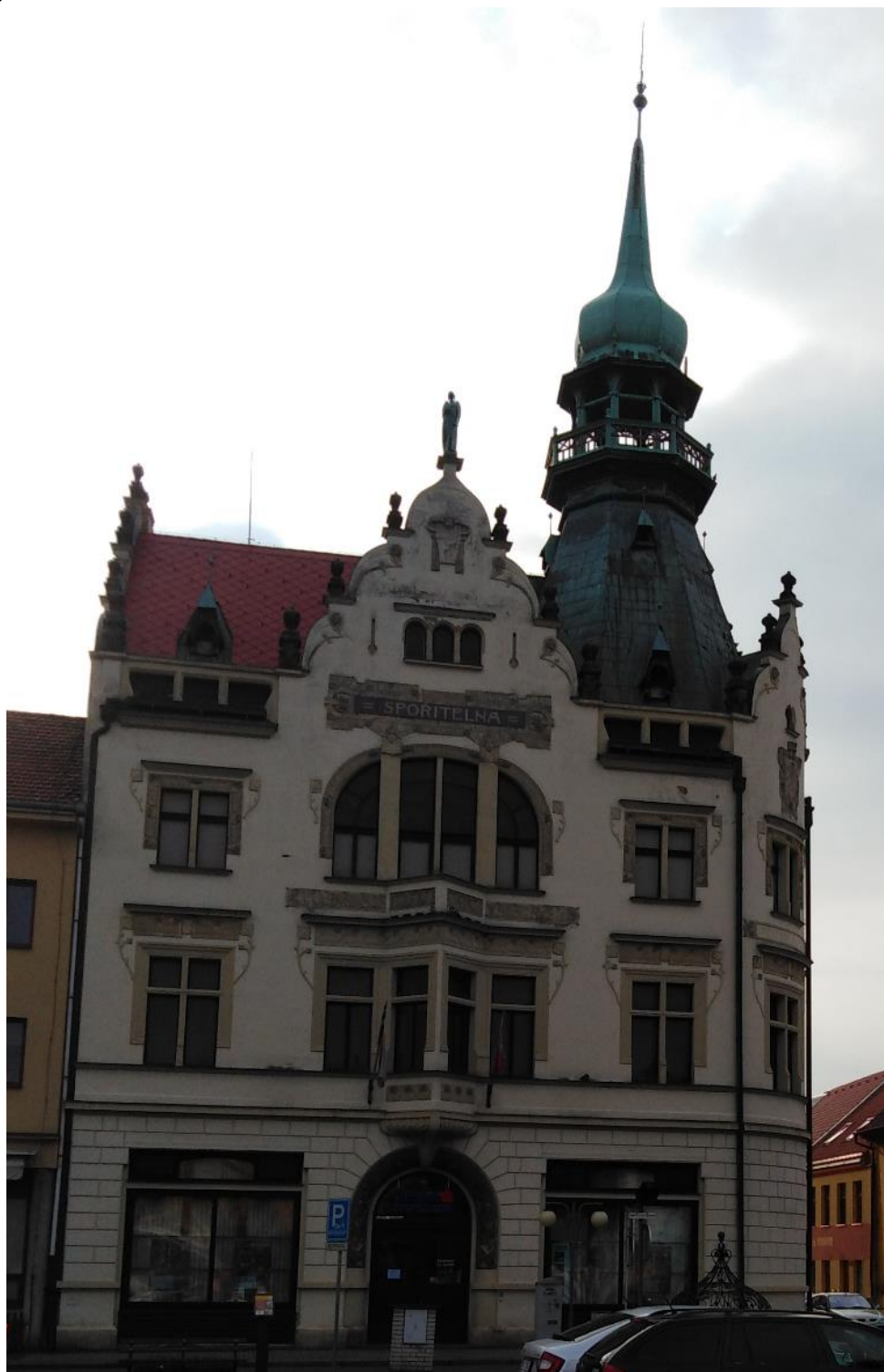
Dům čp. 507, západní průčelí
