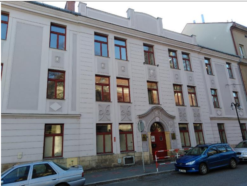
Současná secesní podoba budovy čp. 78, severní průčelí
