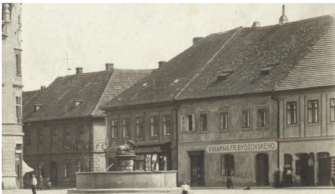
Dům čp. 498 uprostřed v zástavbě na fotografii kolem r. 1910, ještě střídmě zdobený s původním ostěním 202
