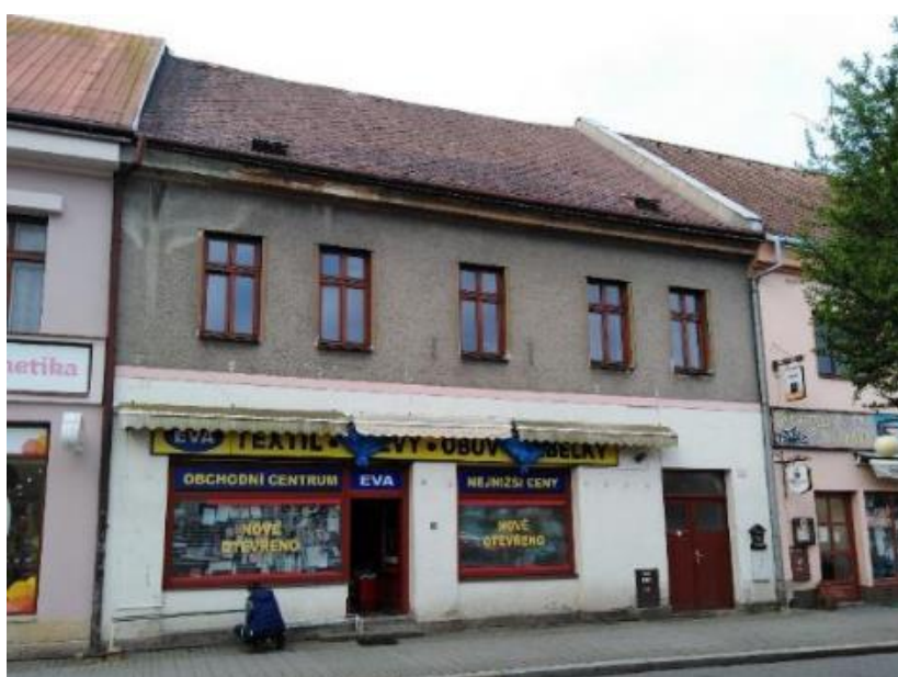
Dům čp.498, současný stav průčelí
