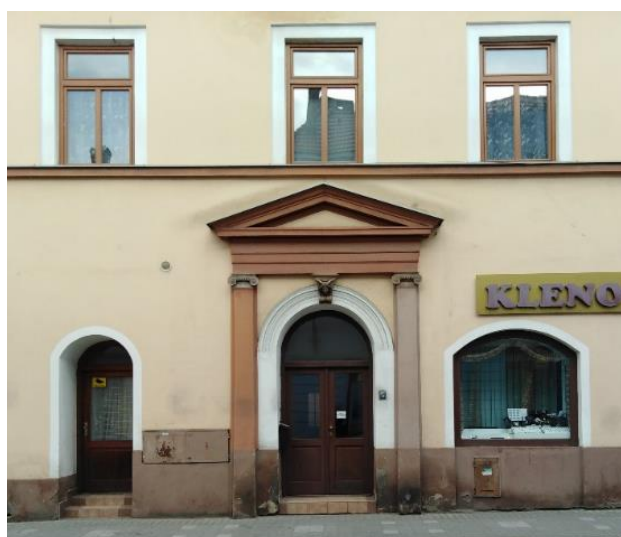
Detail hlavního vstupu z Revoluční tř., dům čp. 18, zrekonstruovaný portál ve zjednodušené podobě navazuje na ten původní
