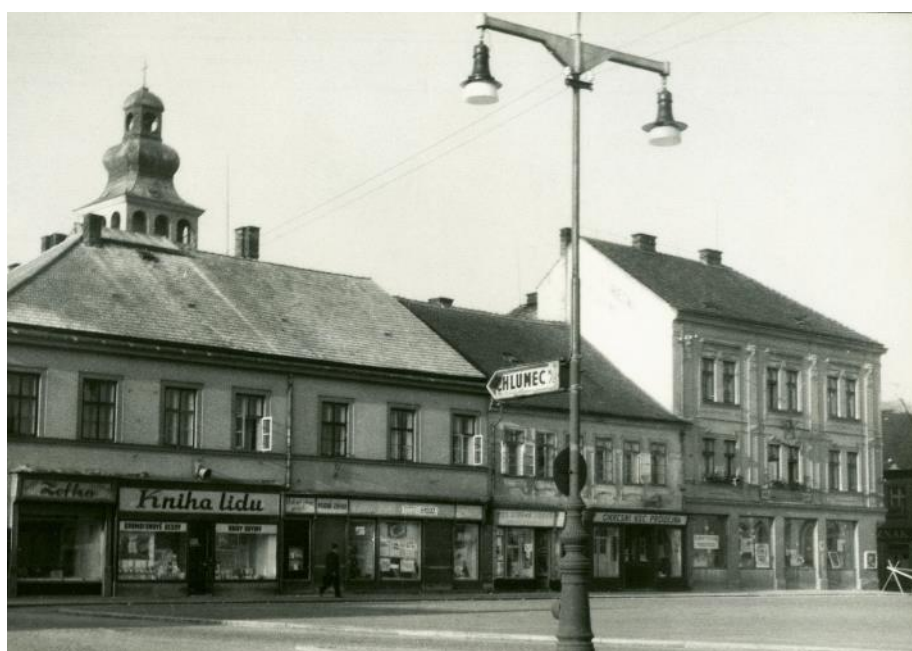
Dům čp. 16 na fotografii z 2. pol. 20. stol. (vpravo), zde ještě s charakteristickými sduženými okny a se sedlovou střechou 174
