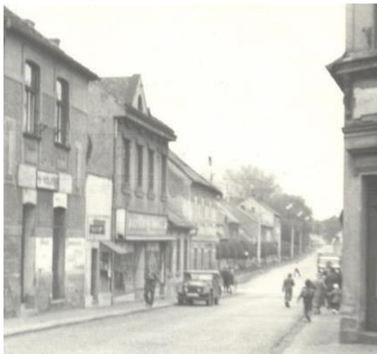
Dům čp. 1162 (v zástavbě uprostřed) na fotografii z r. 1969, 293 parter již nejspíše upravený, patro ještě v původní podobě.
