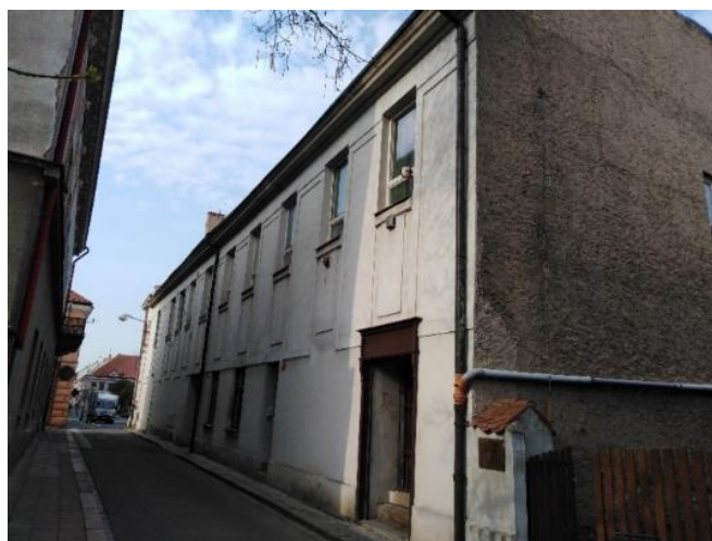
Dům čp. 1143, pohled na východní průčelí z ulice U Památníku
