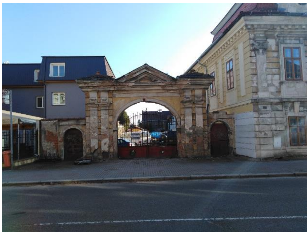
Vjezdová brána a vedle část východního průčelí, Doležalův dvorec čp. 103
