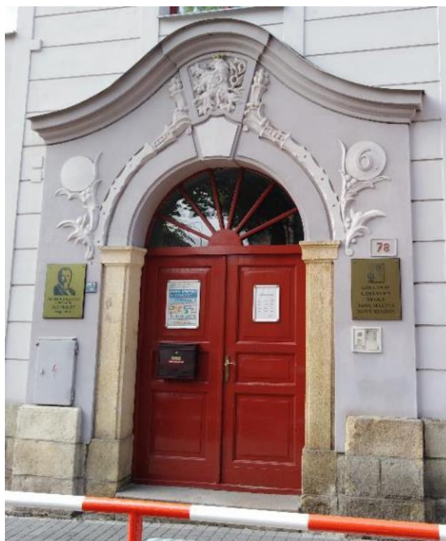
Detail vstupního portálu budovy čp. 78 s charakteristickou výzdobou. Lev nahoře ve výseči představuje znak Nového Bydžova, šestka v kruhu vpravo od světlíku původní číslo popisné
