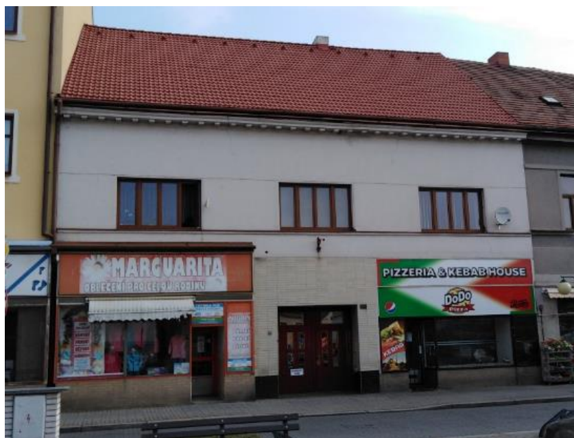
Současný stav jižního průčelí domu čp. 1461. Po původním podloubí navenek ani stopy...
