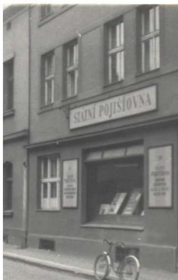
Část domu čp. 1133 na fotografii z r. 1969, zde ještě s původním výkladním oknem 273
