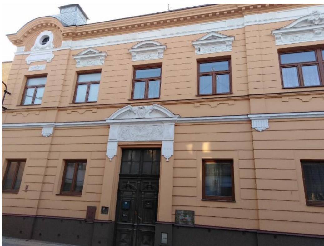
Část východního průčelí domu čp. 1506
