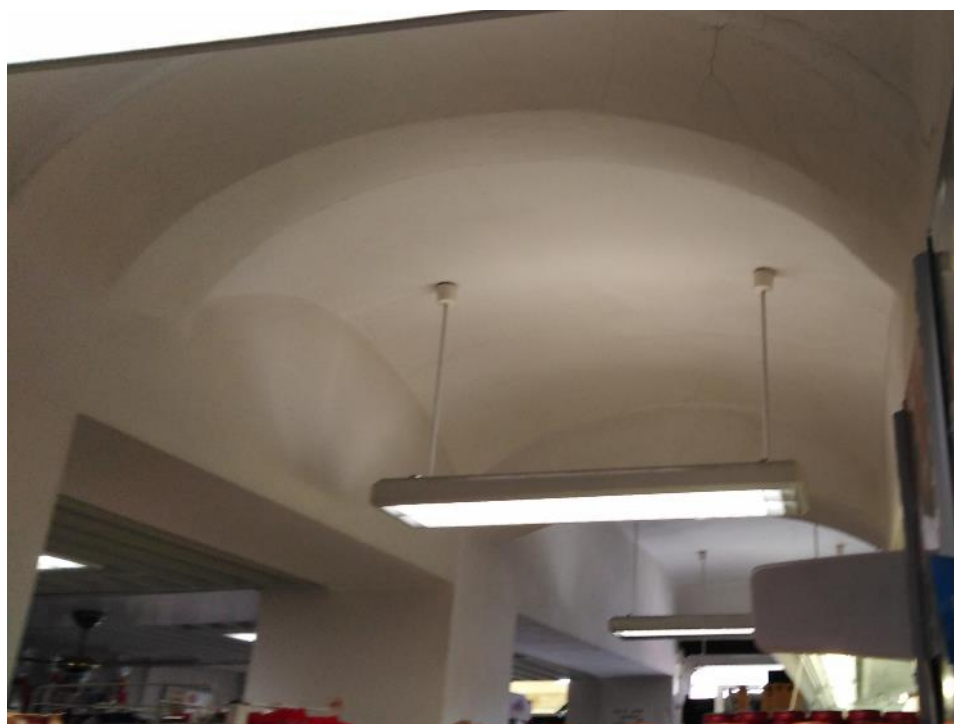
Interiér přízemí domu čp. 1145, detail klenby.
