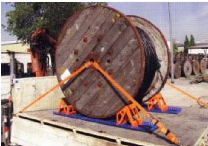
Obrázek 22 Zajištění kabelového bubnu
