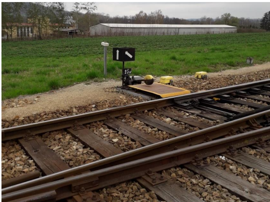
Obrázek 9 – Výměna opatřená samovratným přestavníkem v dopravně RB Bavorov
