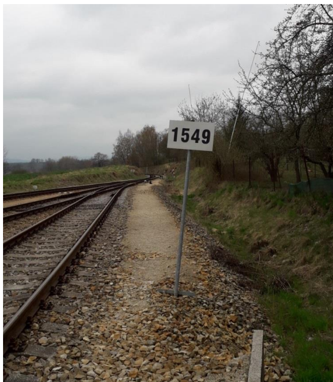
Obrázek 4 – Návěst Číslo dopravní pro udělení odhlášky umístěná v každé dopravně RB i autonomní dopravně
