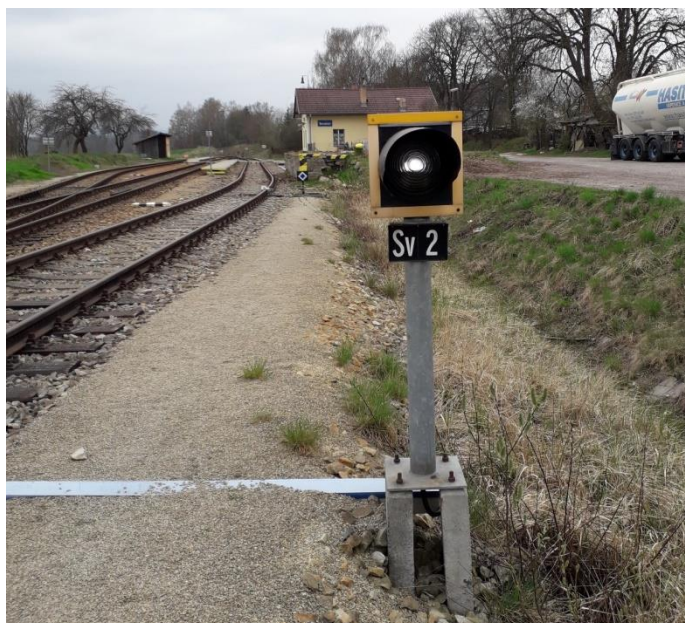
Obrázek 7 – Návěstidlo výměny se samovratným přestavňákem v dopravně RB Bavorov s návěstí Jízda vlaku zajištěna
