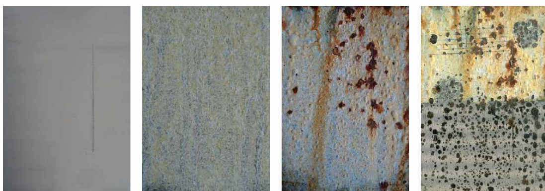
Nátěrové filmy s obsahem ZnFe_2O_4 OKP=5% před expozicí, po 120 hodinové expozici, 1056 hodinové expozici a ocelový panel po odstranění nátěrového filmu
