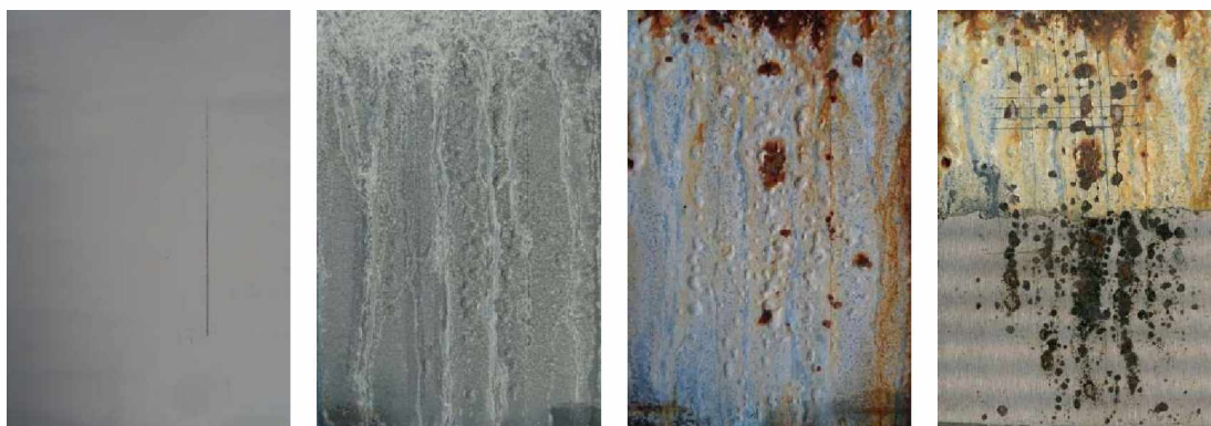
Nátěrové filmy s obsahem ZnFe_2O_4/PPY OKP=5% před expozicí, po 120 hodinové expozici, 1056 hodinové expozici a ocelový panel po odstranění nátěrového filmu
