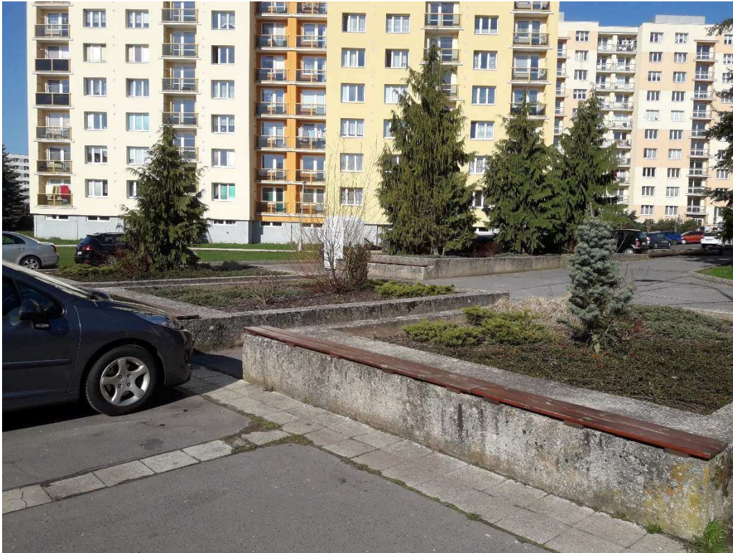
Obrázek 15: Betonové zídky se zelení před ZŠ Mládežnická, které budou odstraněny.
