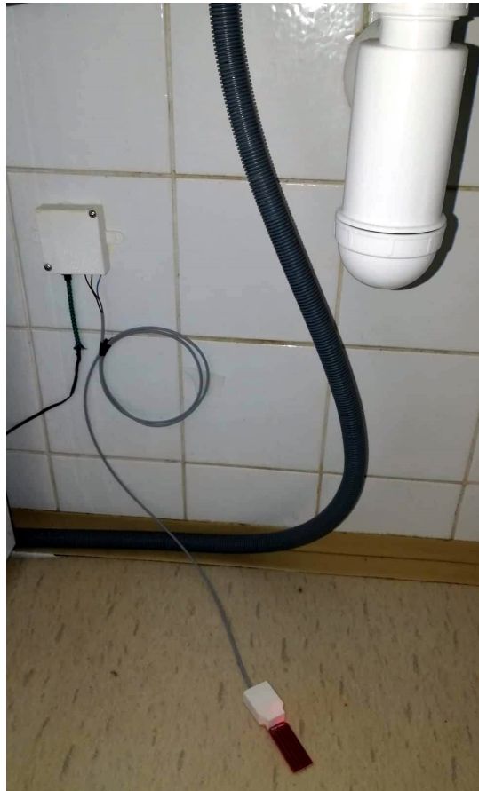
Obr. 1.29 – Umístění jednotky pro detekci vody
