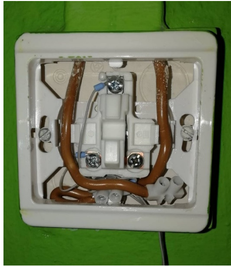
Obr. 1.10 – Zapojení vypínače osvětlení
