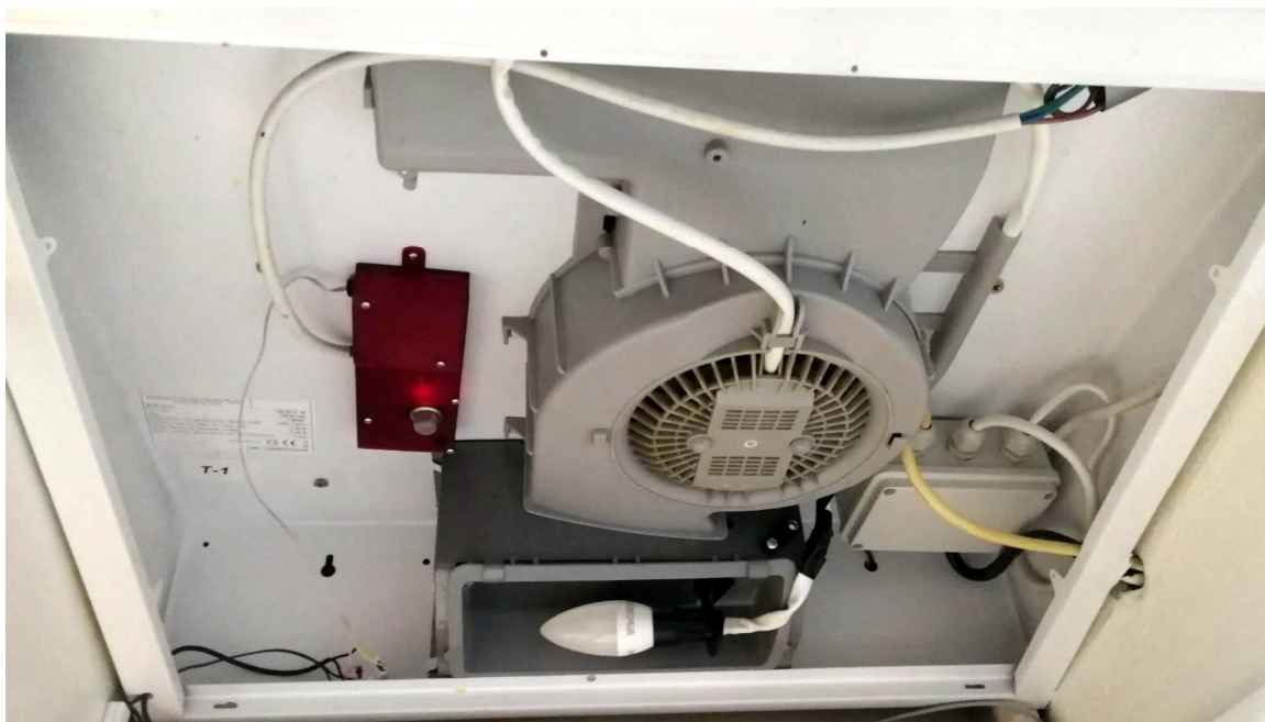
Obr. 1.23 – Umístění jednotky pro ovládání digestoře, detekci plamene a plynu
