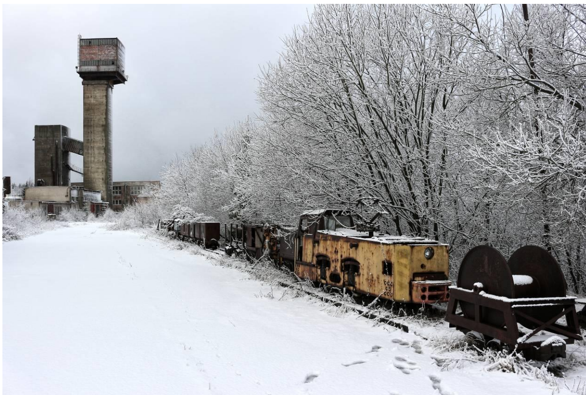
Obrázek 4 - Přes 20 let opuštěný důl na železnou rudu
