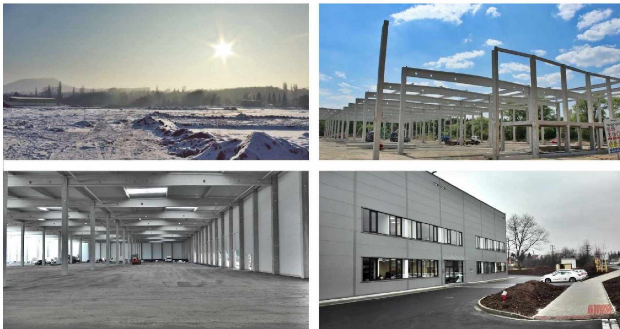
Obrázek 28 Výstavba Terminálu 4 (SAMBULAR, 2017)
