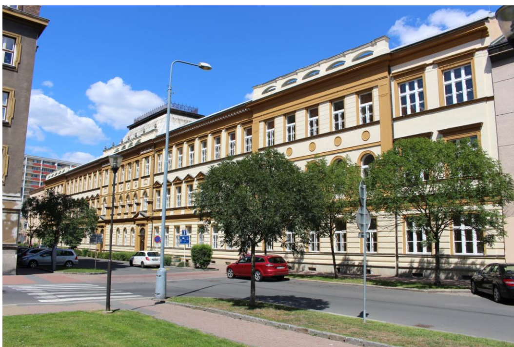
Obr. č. 6: Budova bývalé Novoměstské obecné školy, současnost. 246
