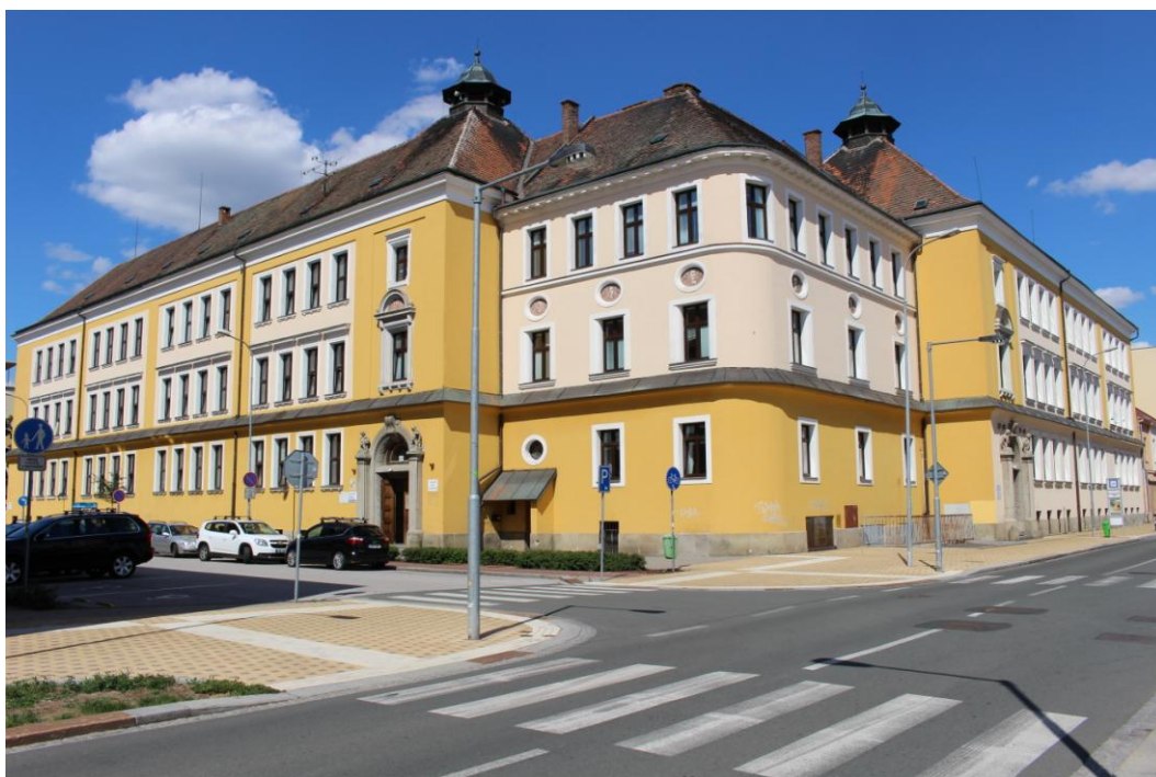
Obr. č. 12: Budova bývalé školy Na Skřivánku, současnost. 252
