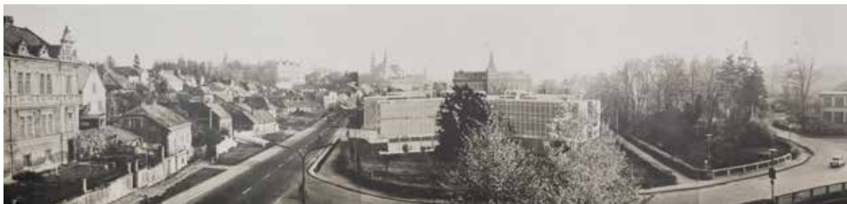
Obr. 7 Ivo Loos – Jindřich Malátek, objemová studie sídliště Komenského náměstí (U Smutného mostu) – pohled od severu, 1971 . Foto: SOkA Svitavy se sídlem v Litomyšli, fond MNV Litomyšl, nezařazený přírůstek
