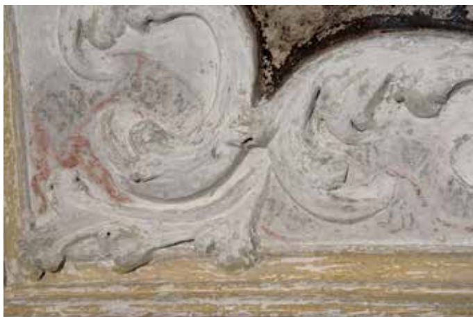
Obr. 7. Klanění pastýřů na vítězném oblouku, detail štukového pole pod výjevem. Stav před restaurováním (nahore). Stav po odstranění druhotných nátěrů s patrnou částí latinského verše (dole). Foto: Martina Poláková, 2015.
