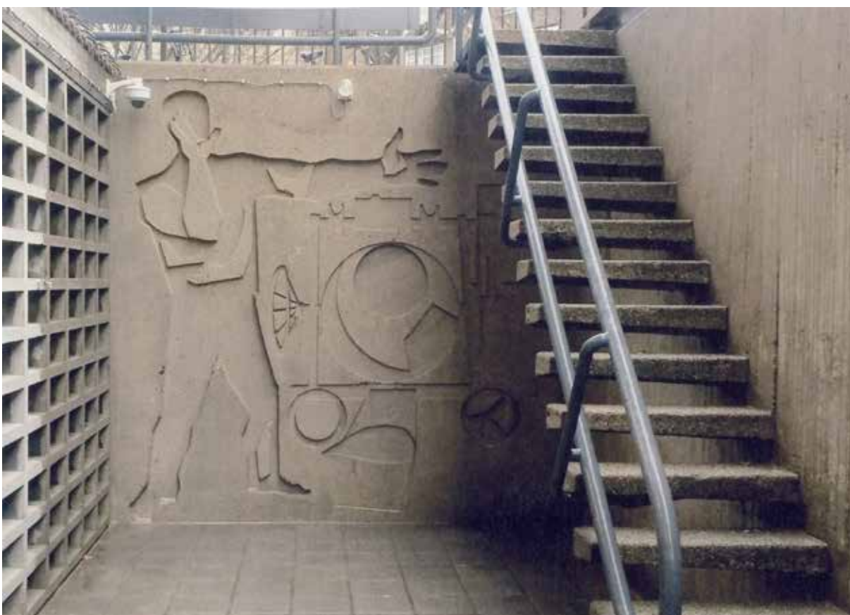
Obr. 3, obr. 4 Henry op de Laak, De betonomolenman , přemalovaný betonový reliéf na Eerste Christelijke Technische School Patrimonium v Amsterdamu z roku 1956. Na další fotografii stav v roce 2015. Během restaurování po roce 2009 byly barevné vrstvy z reliéfu odstraněny. Repro z knihy Anita Blom – Simone Vermaat – Ben de Vries (eds.), Post-War Reconstruction the Netherlands 1945–1965: The Future of a Bright and Brutal Heritage , Rotterdam 2016.
