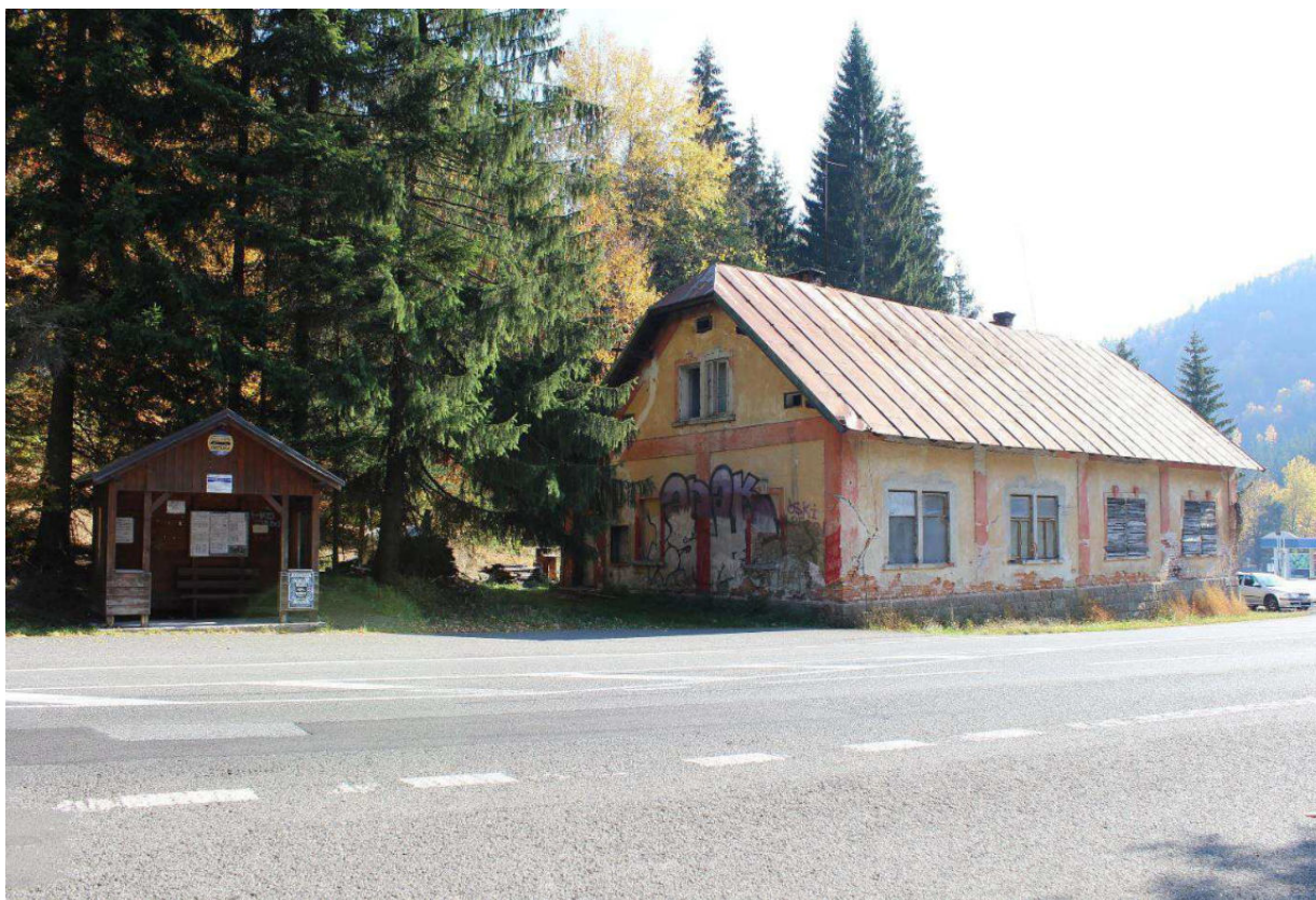
Obrázek 21 Budova určená k demolici, vznikne nová bezbariérová autobusová zastávka v zálivu
