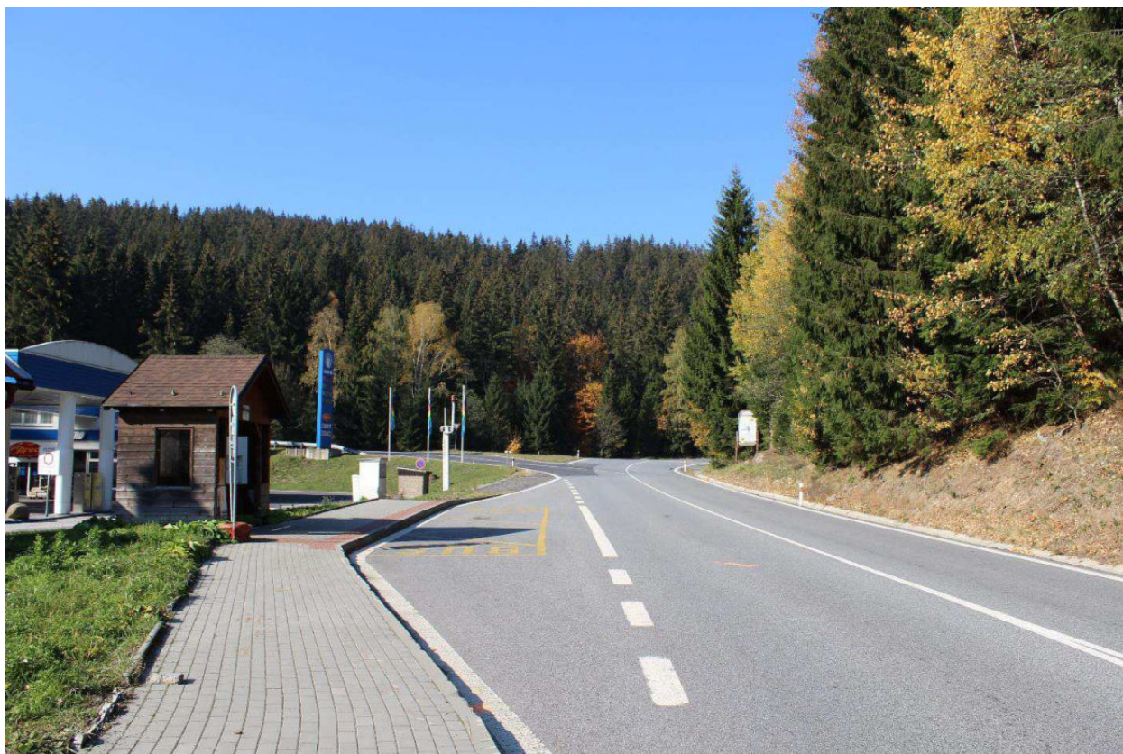
Obrázek 3 Větev 2 – pohled do křižovatky, vybudování nových bezbariérových autobusových zastávek v zálivu
