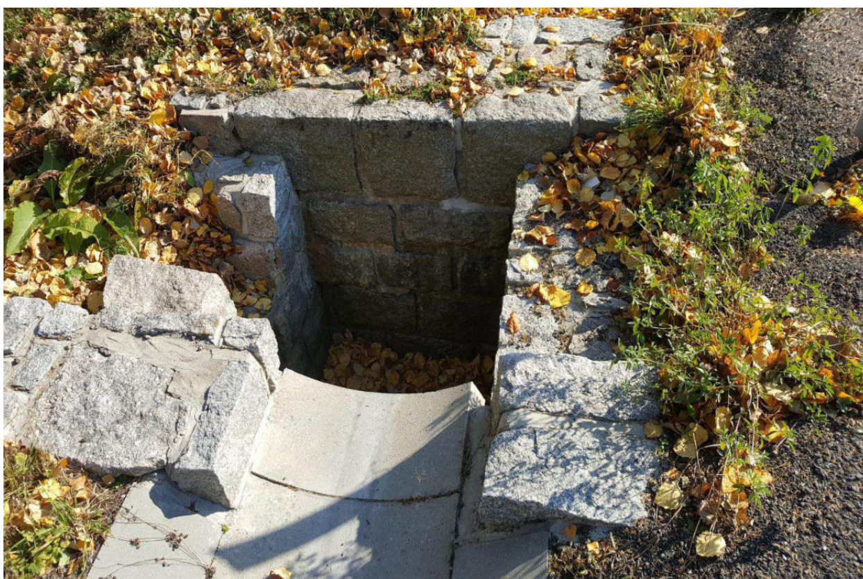
Obrázek 14 Vtoková jímka, odsunutí a vybudování nové vtokové jímky
