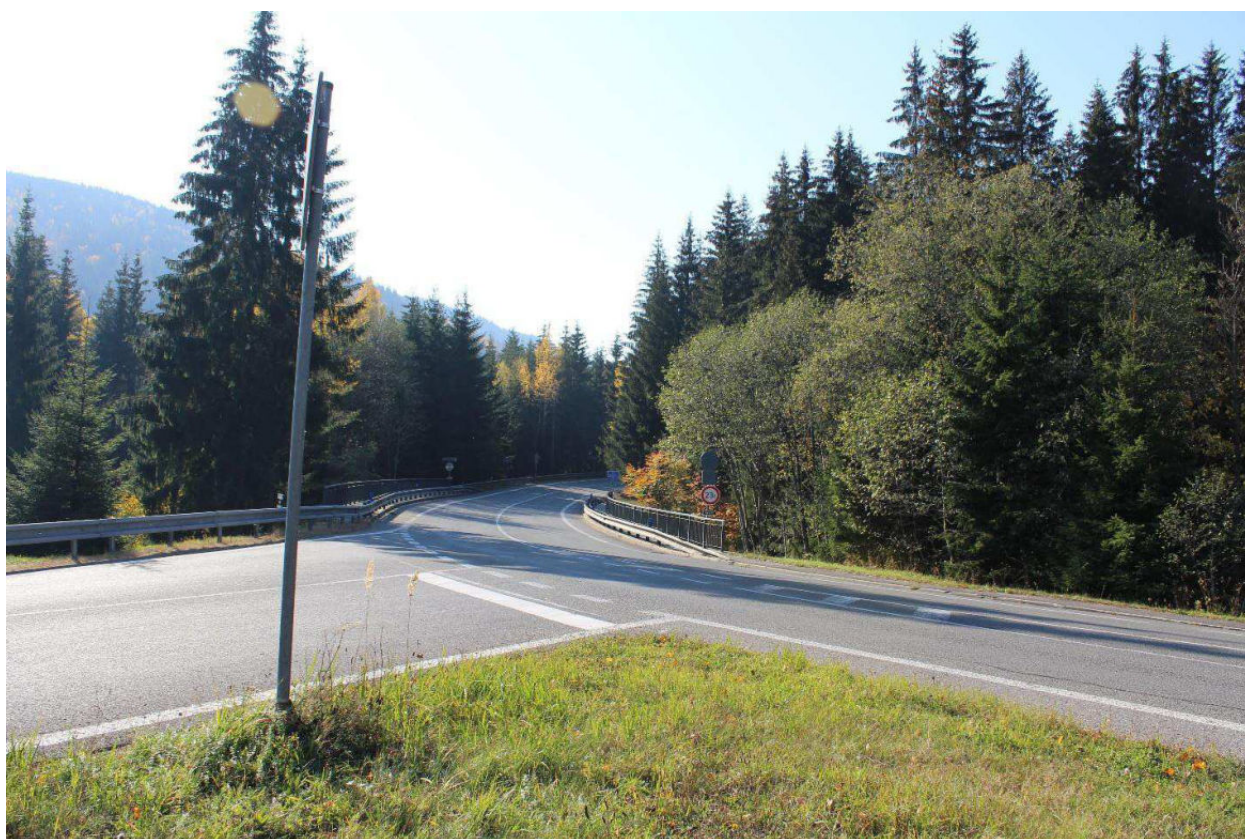
Obrázek 2 Větev 1 – pohled směr Tanvald, nevyhovující rozhledové poměry
