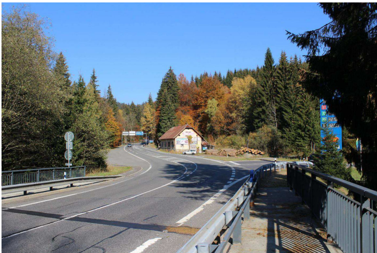
Obrázek 1 Větev 1 – pohled do křižovatky, napojení na stávající most
