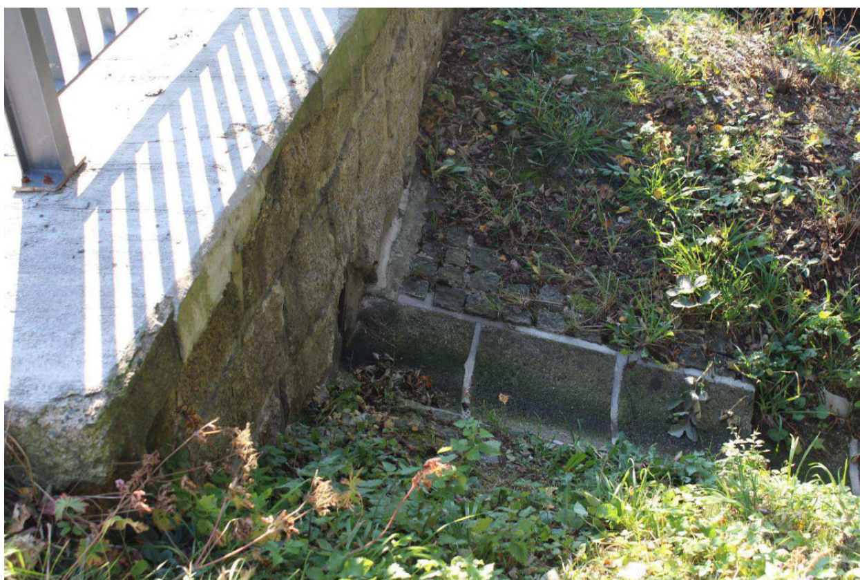
Obrázek 20 Stávající vyústění uličních vpustí z mostu
