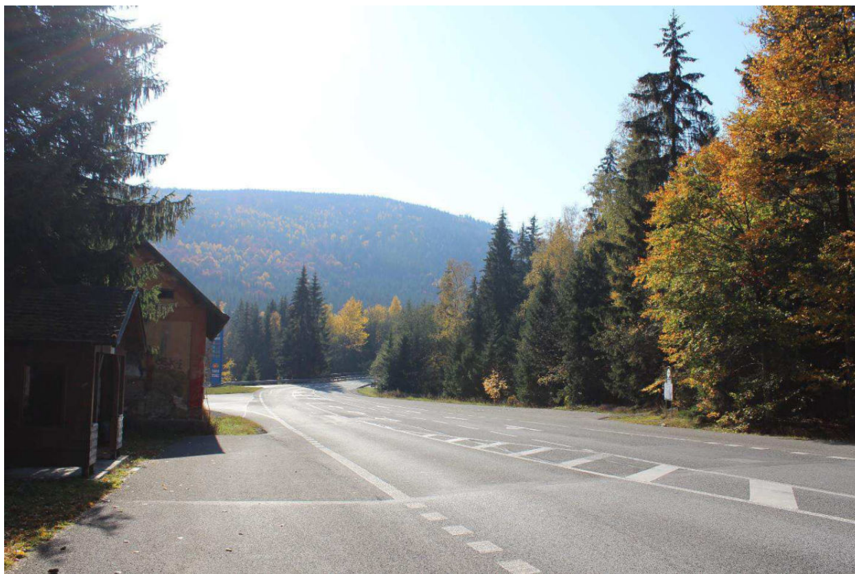
Obrázek 15 Pohled do křižovatky od zastávky č. 3, vybudování nových bezbariérových autobusových zastávek v zálivu
