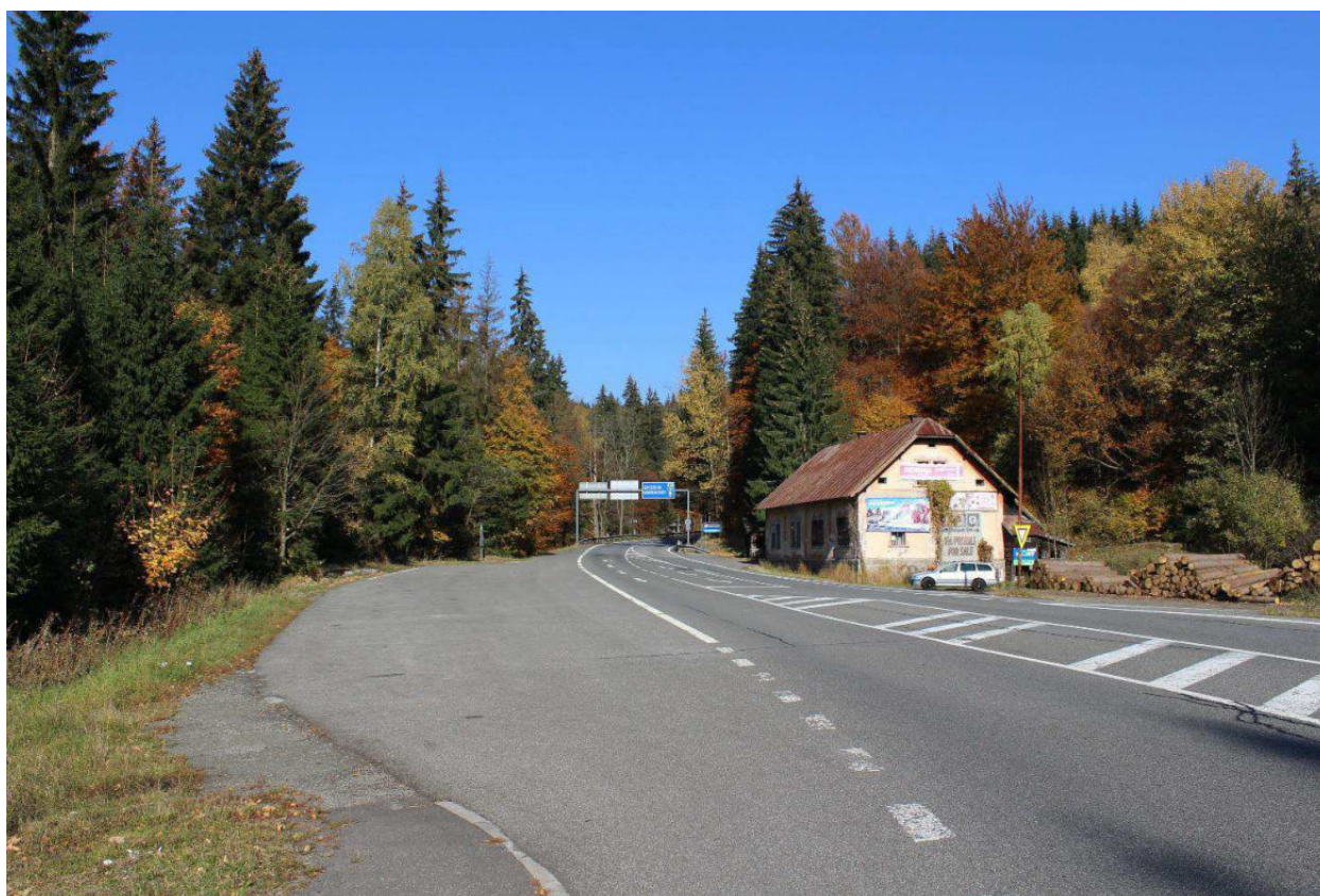
Obrázek 6 Větev 3 – pohled směr Harrachov, vybourání nevyužívané asfaltové plochy
