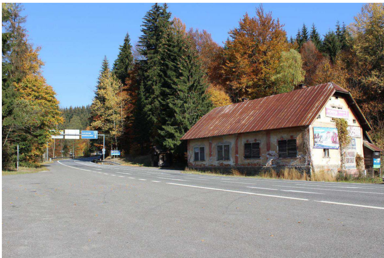
Obrázek 16 Pohled na autobusové zastávky č. 2 a 3, demolice budovy, vybudování nových bezbariérových autobusových zastávek v zálivu
