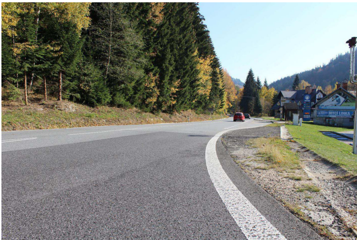
Obrázek 11 Větev 2 – pohled na svah, nutný zářez a vykácení stromů pro nově zbudovanou bezbariérovou autobusovou zastávku v zálivu
