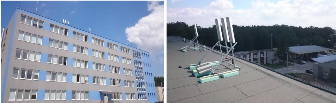
Obrázek 75 - Zkonstruovaná řídká anténní řada fázového interferometru na budově firmy T-CZ
