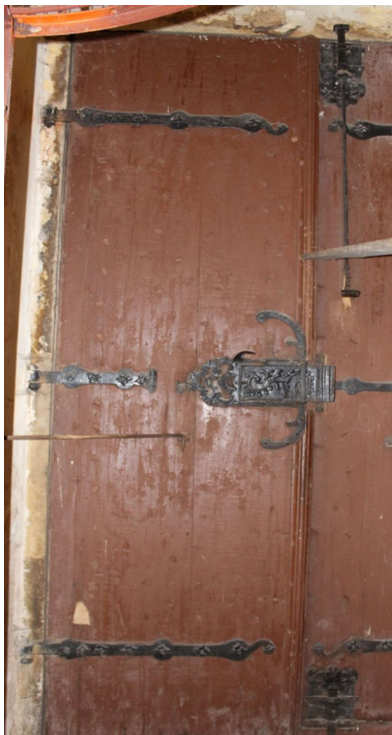
17) Rubová, nosná strana dveří západního průčelí. Foto: autor.
