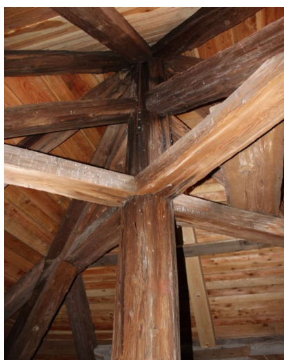
12) Středový sloupek krovu věže s rozpěrami. Foto: autor.
