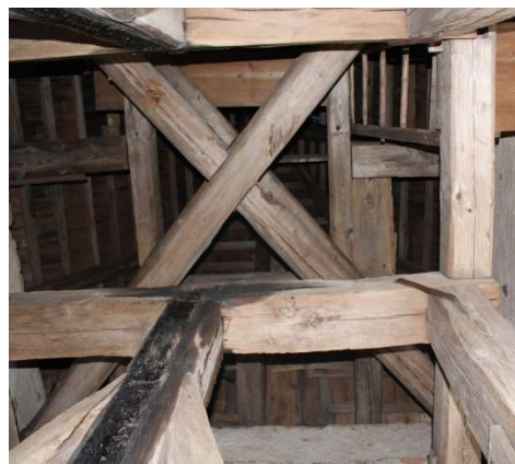
10) Trámová základna krovu věže s konstrukcí zvonové stolice. Foto: autor.
