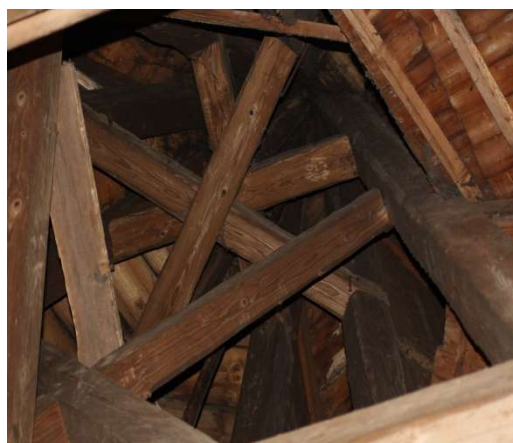
10) Středový sloupek se ztužením krovu nad presbyteriem. Foto: autor.
