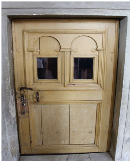
13) Lícová strana dveří sakristie. Foto: autor.
