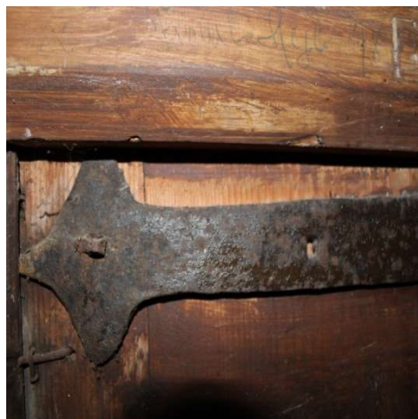
18) Detail zakončení pásového závěsu dveří - schodiště na kruchtu. Foto: autor.
