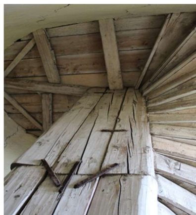
12) Středový sloupek krovu věže s rozpěrami. Foto: autor.
