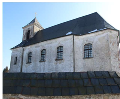
Obr. 31: Kostel Narození Panny Marie - severní průčelí. Foto: autor.
