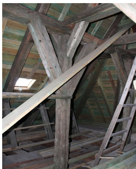
10) Středový sloupek se ztužením krovu nad presbyteriem. Foto: autor.
