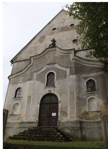
Obr. 25: Kostel sv. Archanděla Michaela - západní průčelí. Foto: autor.
