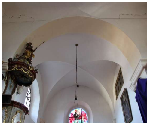
4) Zaklenutí presbyteria a vítězný oblouk. Foto: autor.
