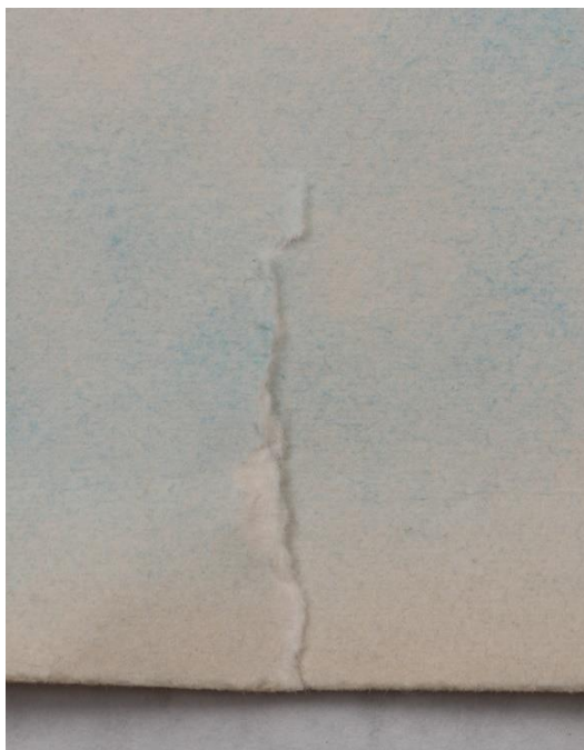
Obr. 17. Detail trhliny, líc, stav před restaurováním, zábleskové světlo
