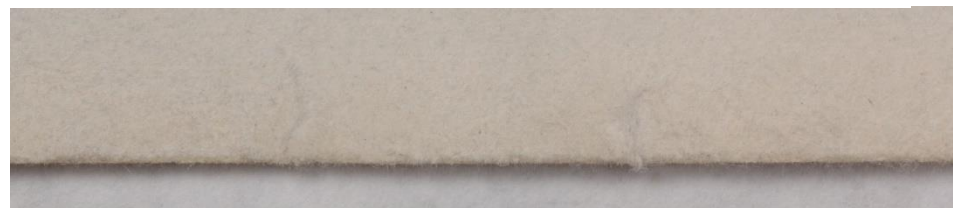
Obr. 22. Detail trhlín, líc, stav po restaurování, zábleskové světlo
