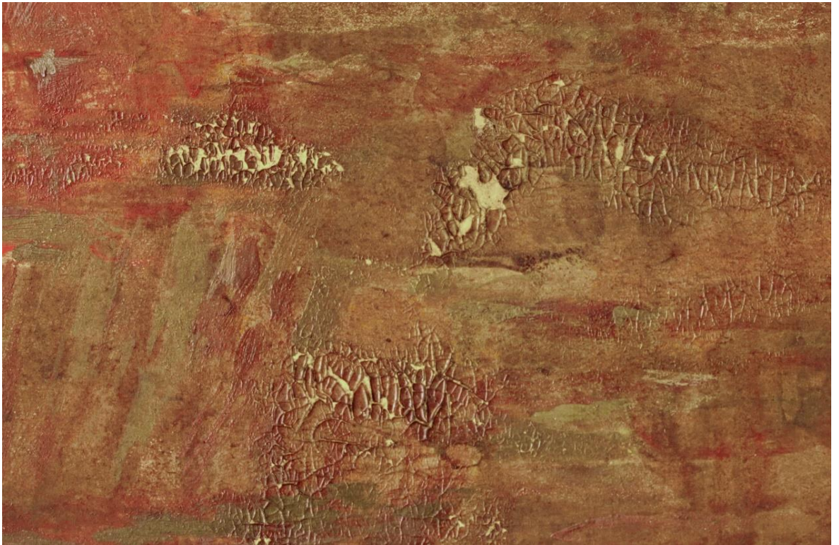
Obr. 30. Detail krakeláže, stav před restaurováním, denní rozptýlené světlo
