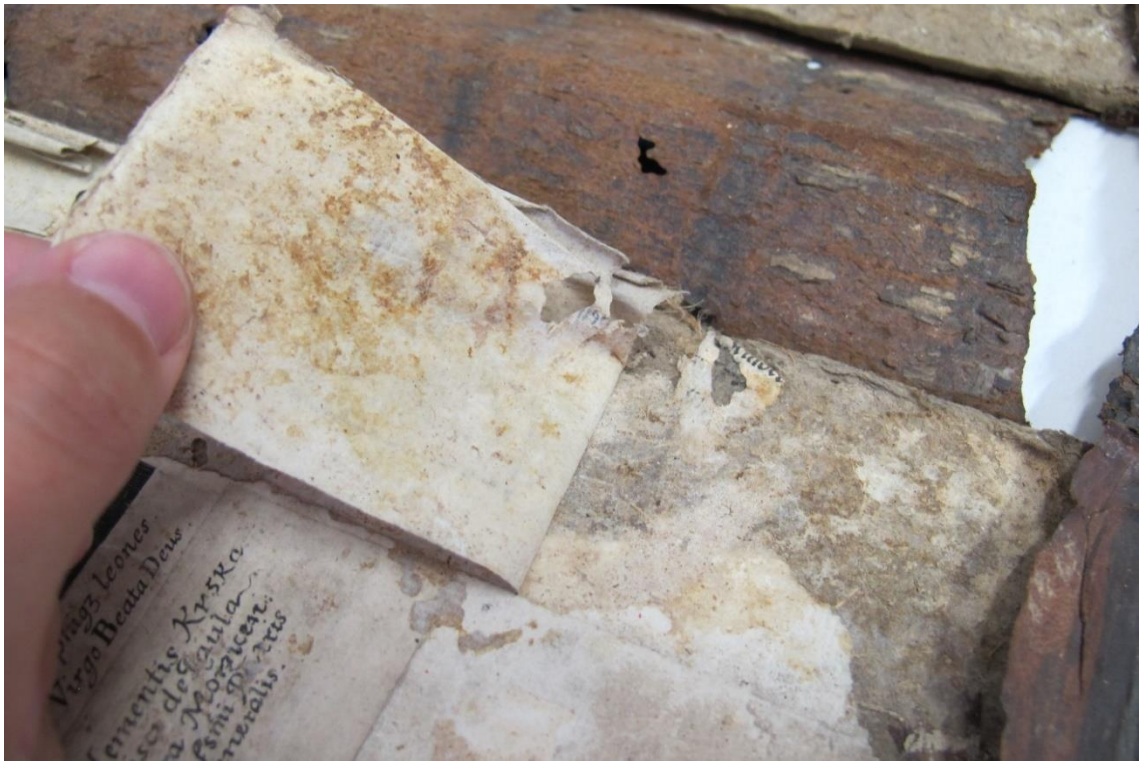
Fotografie 63 Odstranění výlepů z přideští
