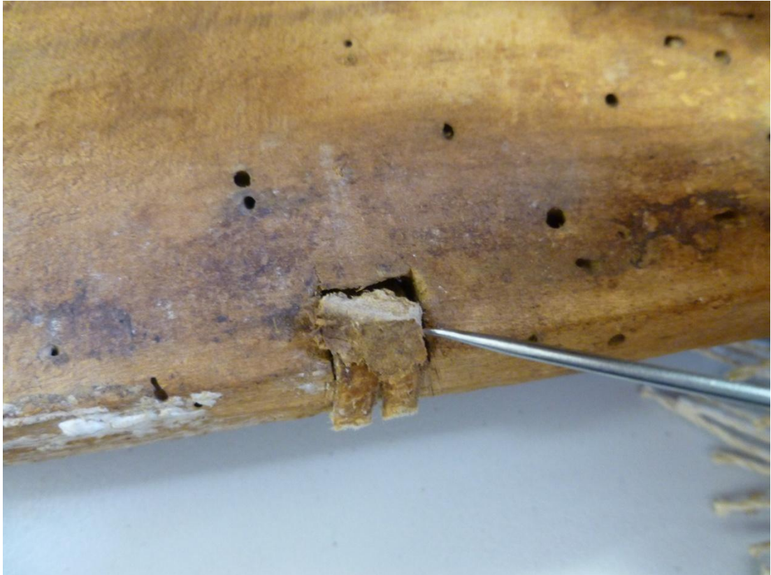
Obrázek 62: Vyjmutí výplně u vazu v desce
