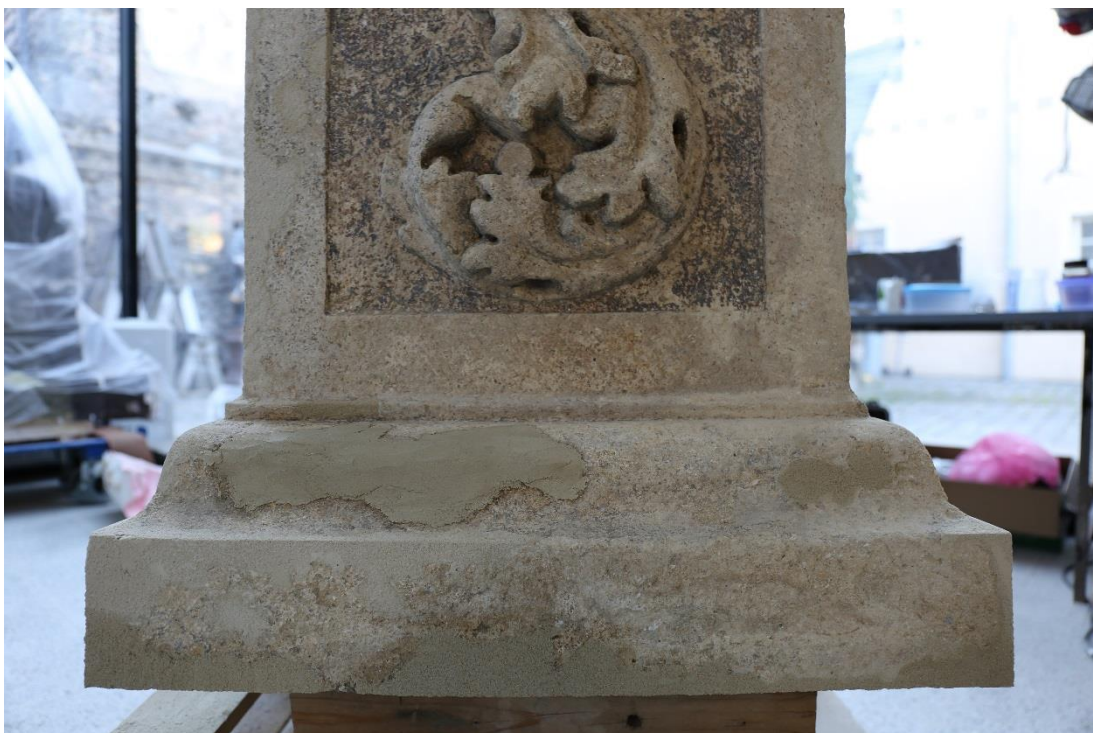
Obr. 106 Postament, průběh tmelení vylomených hran
