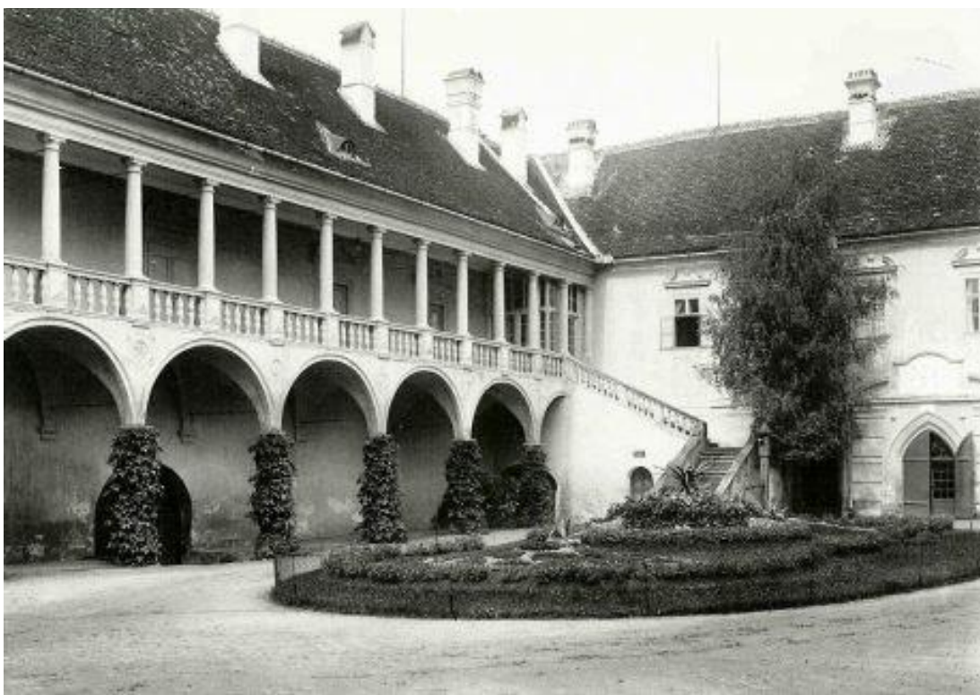
Obr. 180 Hlavní nádvoří - arkáda západního křídla a severní křídlo - historická fotografie z 20. let 20. století. Fond G 169 RA, Moravský zemský archiv v Brně.
