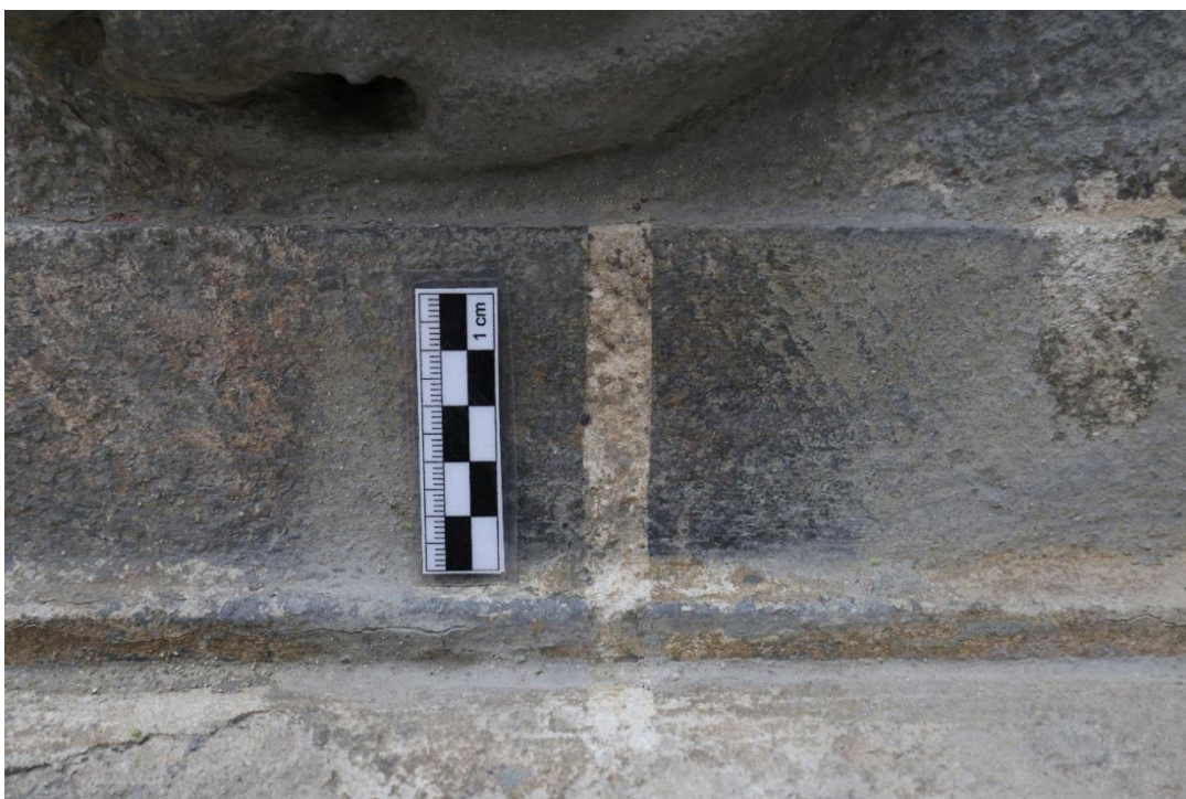
Obr. 94 Postament, stav v průběhu restaurátorského průzkumu-zkouška redukce sádroncové krusty
