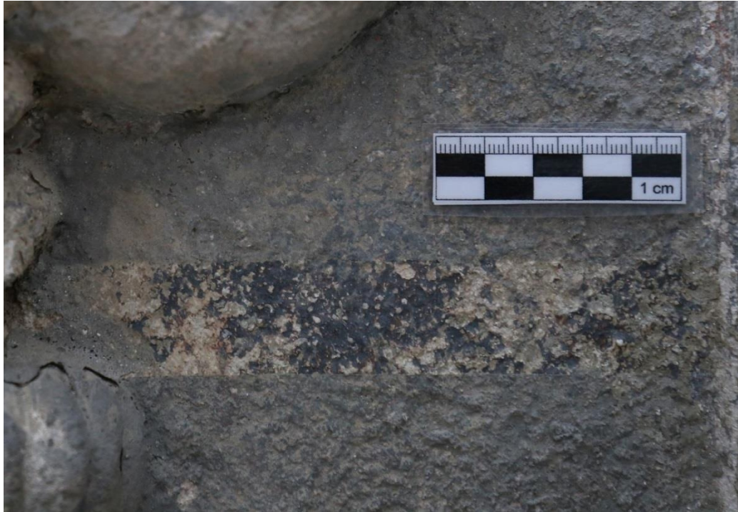
Obr. 95 Postament, zkouška odstraňování cementového nátěru pomocí laseru
