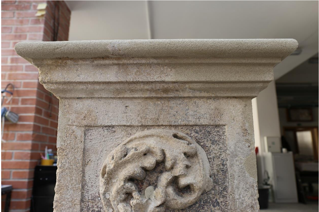
Obr. 104 Postament, průběh tvarové rekonstrukce poškozených částí
