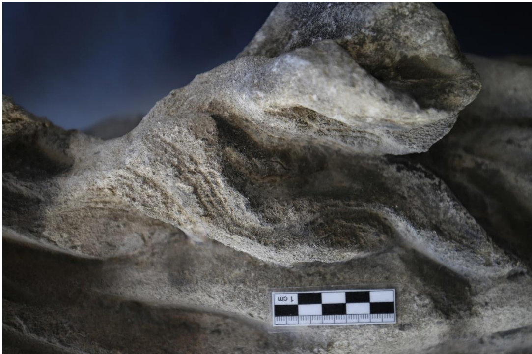
Obr. 51 Stav před čištěním sádrovcové krusty-detail na část drapérie
