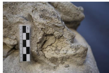
Det. č.1: Degradace a delaminace tmelů
