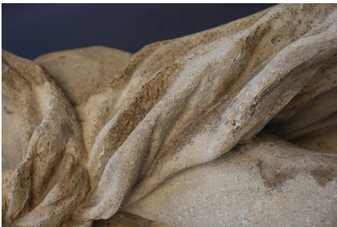
Obr. 54 Stav po očištění povrchu od sádrovcové krusty-detail na drapérii
