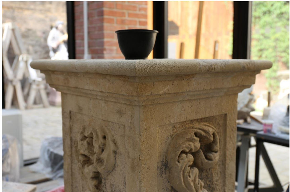
Obr. 105 Postament, průběh tvarové rekonstrukce poškozených částí
