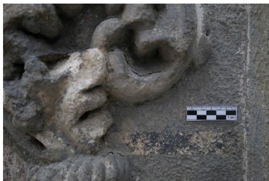
Obr. 18 Postament, zkouška S8 redukce cementového nátěru, na místě, kde je dochované barevné souvrství, zkouška čištění pomocí laseru
