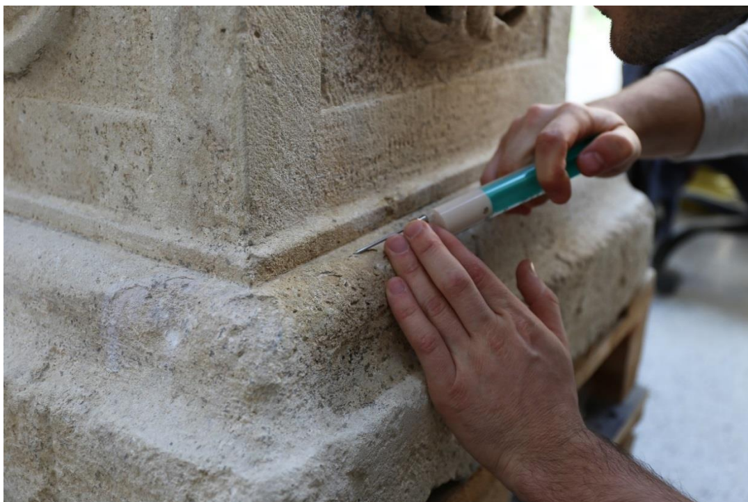
Obr. 102 Postament, průběh restaurování-injektáž prasklin a okrajů defektu na povrchu kamene
