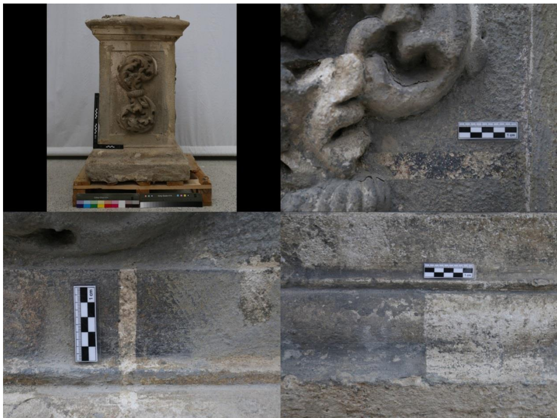
Obr. 36 Restaurátorský průřez zkoušky odstraňování sekundárních cementových tmelů a nátěru na povrchu postamentu
