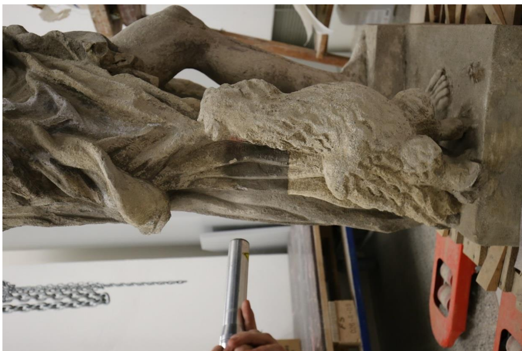
Obr. 42 Průběh čištění laserem-NG: YAG LASER Thunder art
