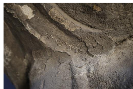
Det. č.9 Sekundární tmely, lomová část, detail.
