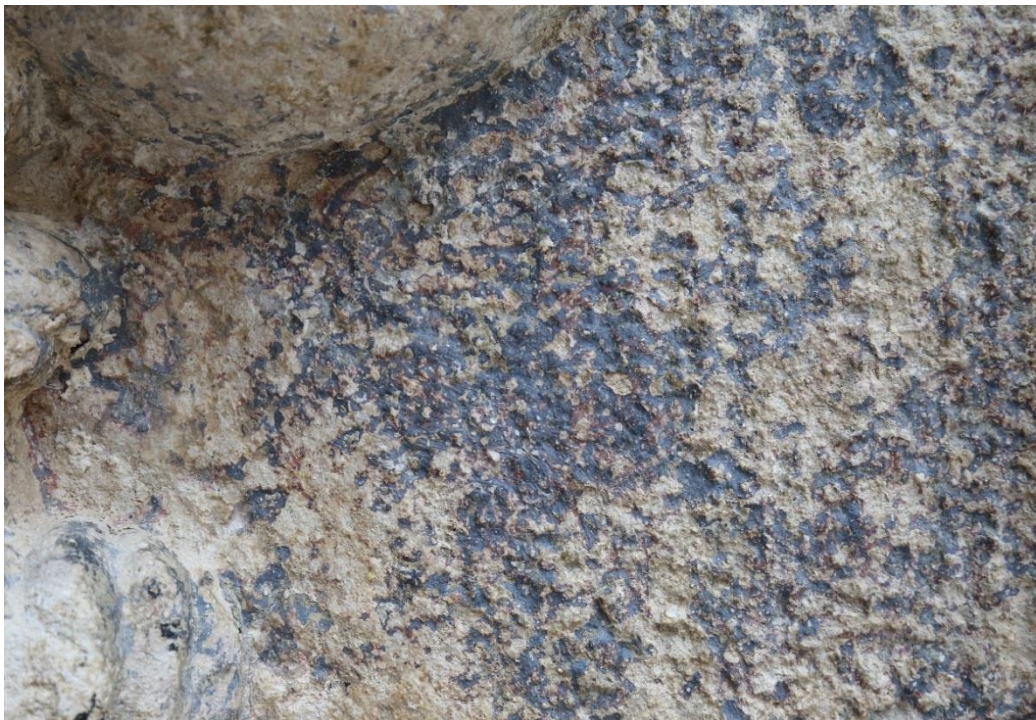
Obr. 96 Postament, stav po odstranění cementového nátěru laserem
