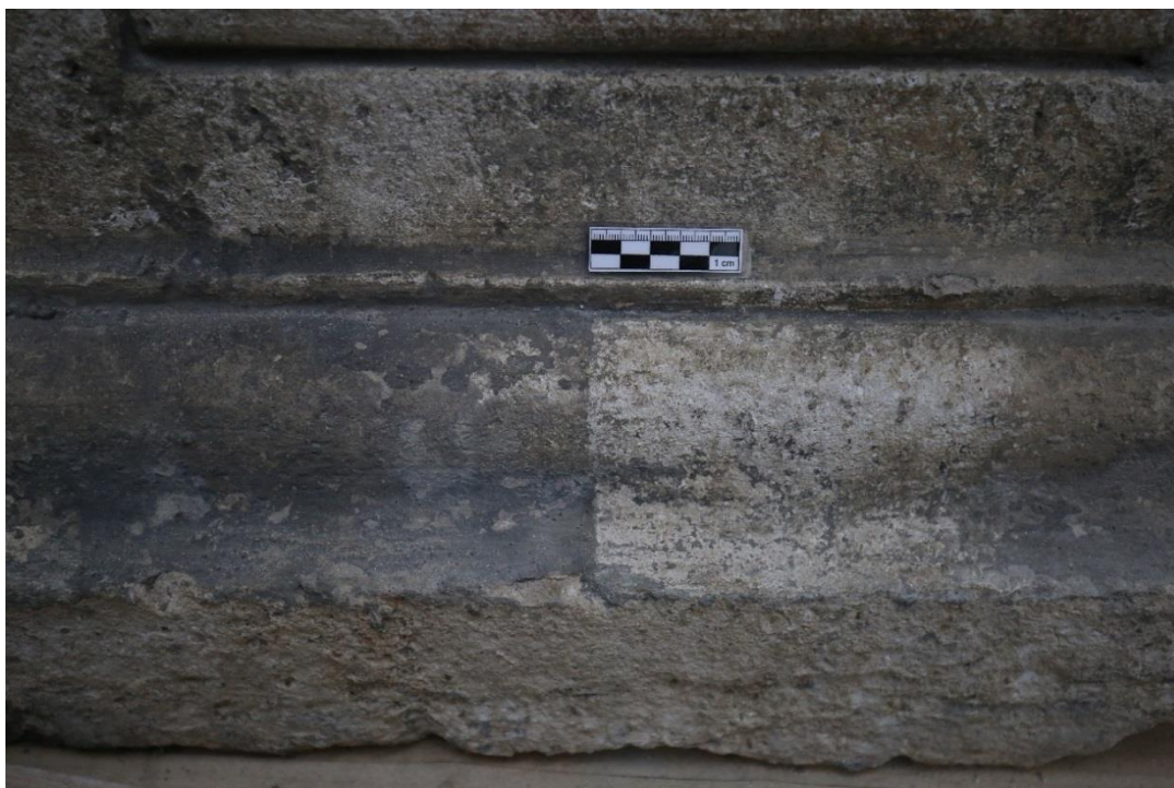
Obr. 93 Postament, stav v průběhu restaurátorského průzkumu-zkouška odstraňování cementové vrstvy
