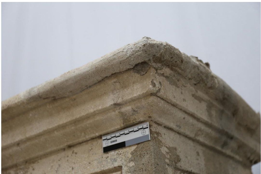
Obr. 90 Postament, stav před restaurováním-detail na sekundární cementový doplněk
