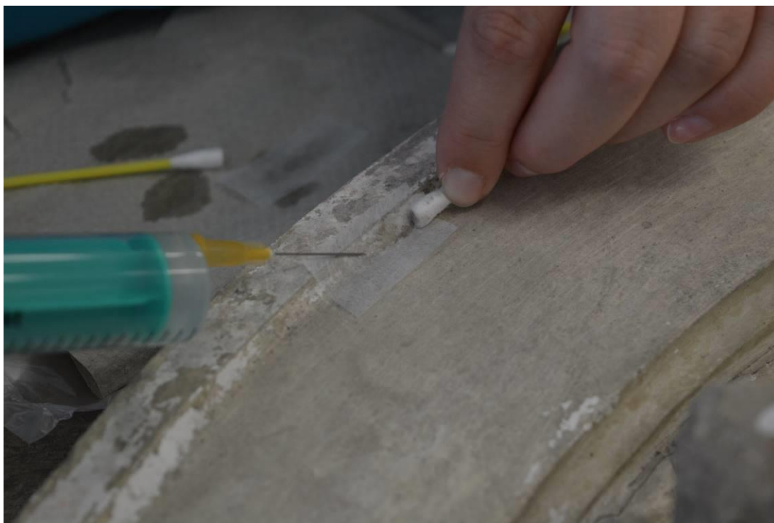
Obr. 54 Zpevňování povrchové úpravy přes japonský papír
