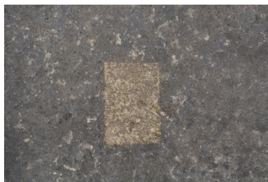
Obr. 3 Zkouška čištění – plocha na pozadí
