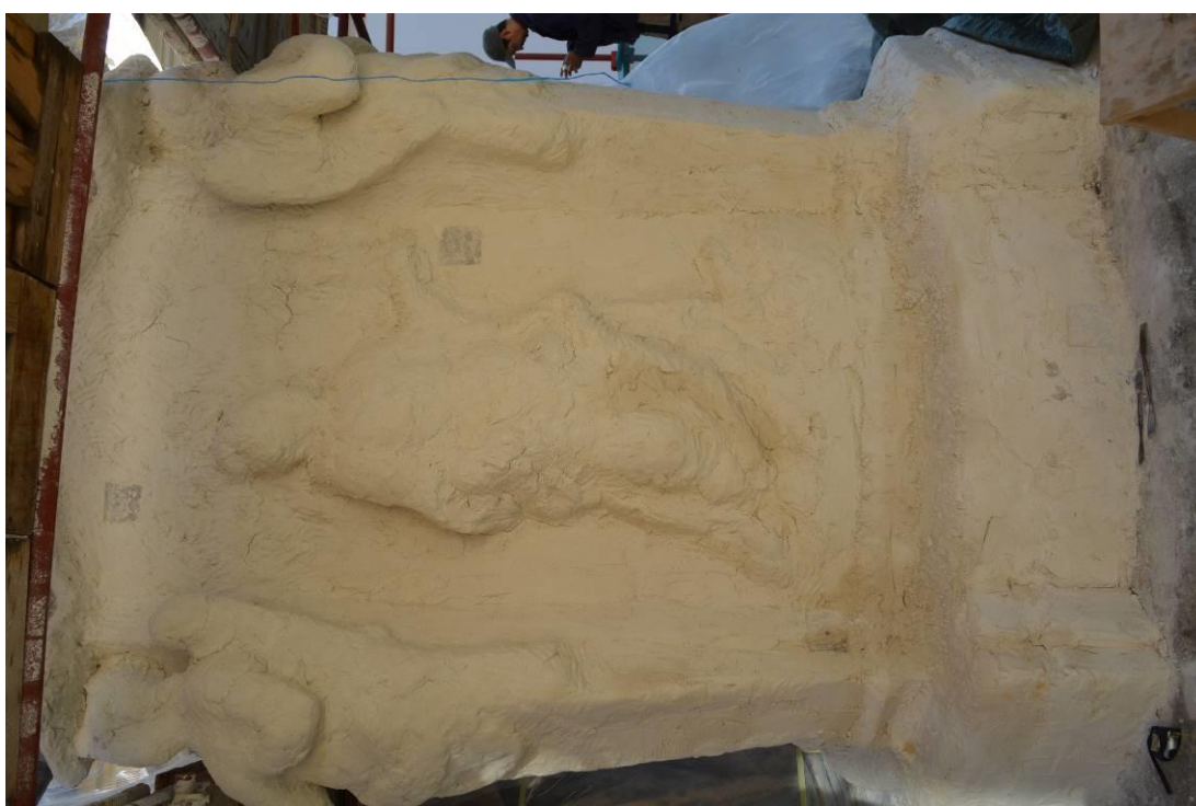
Obr. 22 Odsolovací zábal (s místy odběru vzorků)
