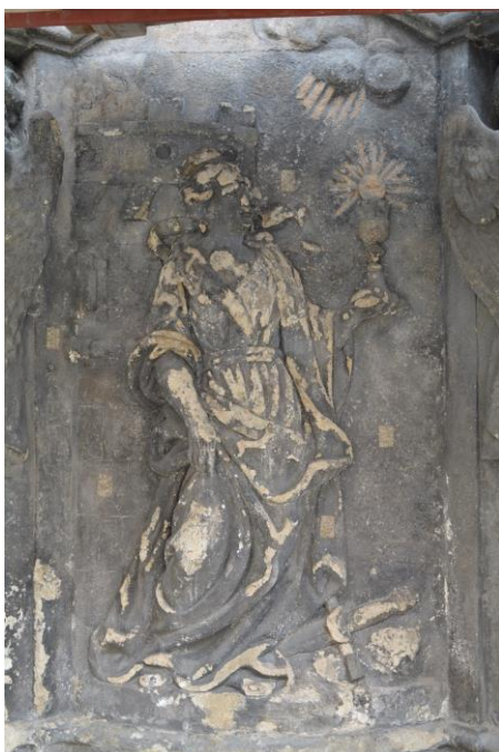
Obr. 6 Celkový pohled na umístění zkoušek čištění
