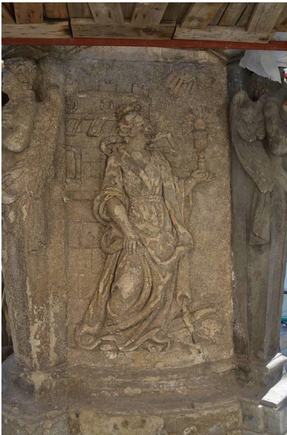
Obr. 20 Po očištění laserem, celkový pohled
