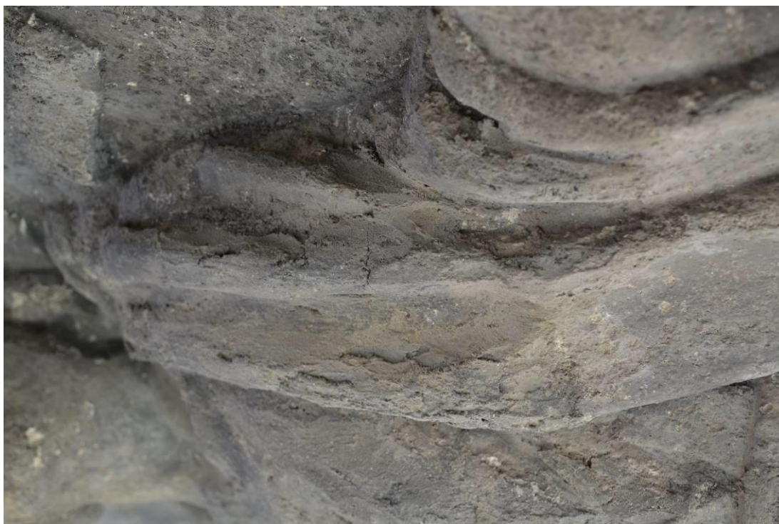
Obr. 13 Stav před restaurováním, nevzhledný tmel
