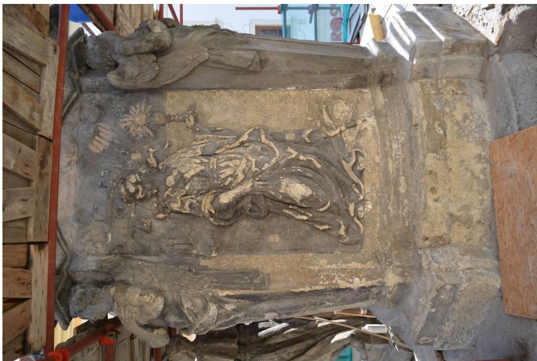
Obr. 19 Čištění laserem, průběh
