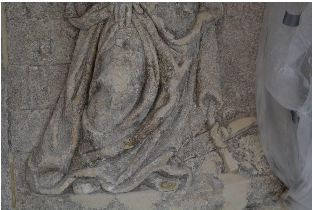
Obr. 25 Po sundání lokálního odsolovacího zábalu, skvrny v záhybu látky kolem kolene
