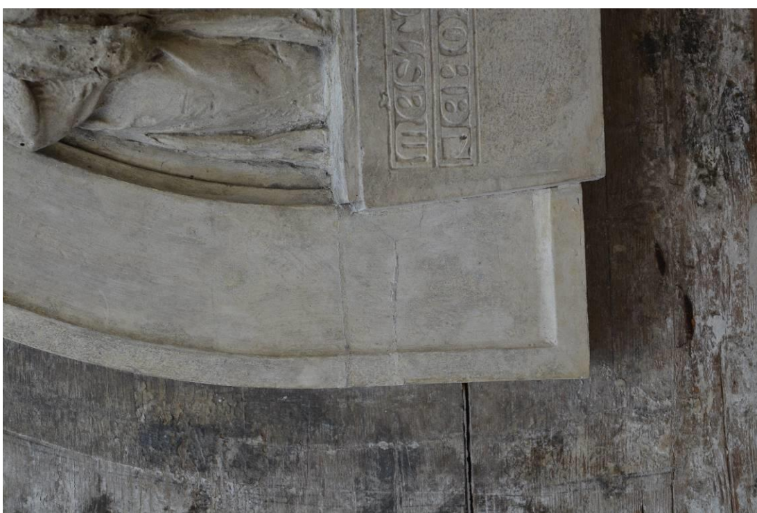
Obr. 69 Stav po restaurování detail
