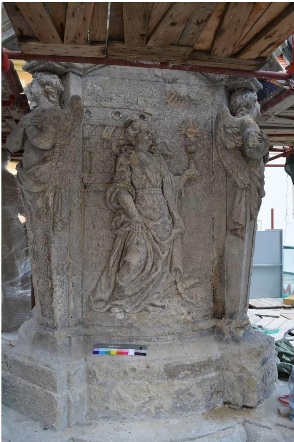
Obr. 26 Očištění po odsolovacích zábalech, celkový pohled
