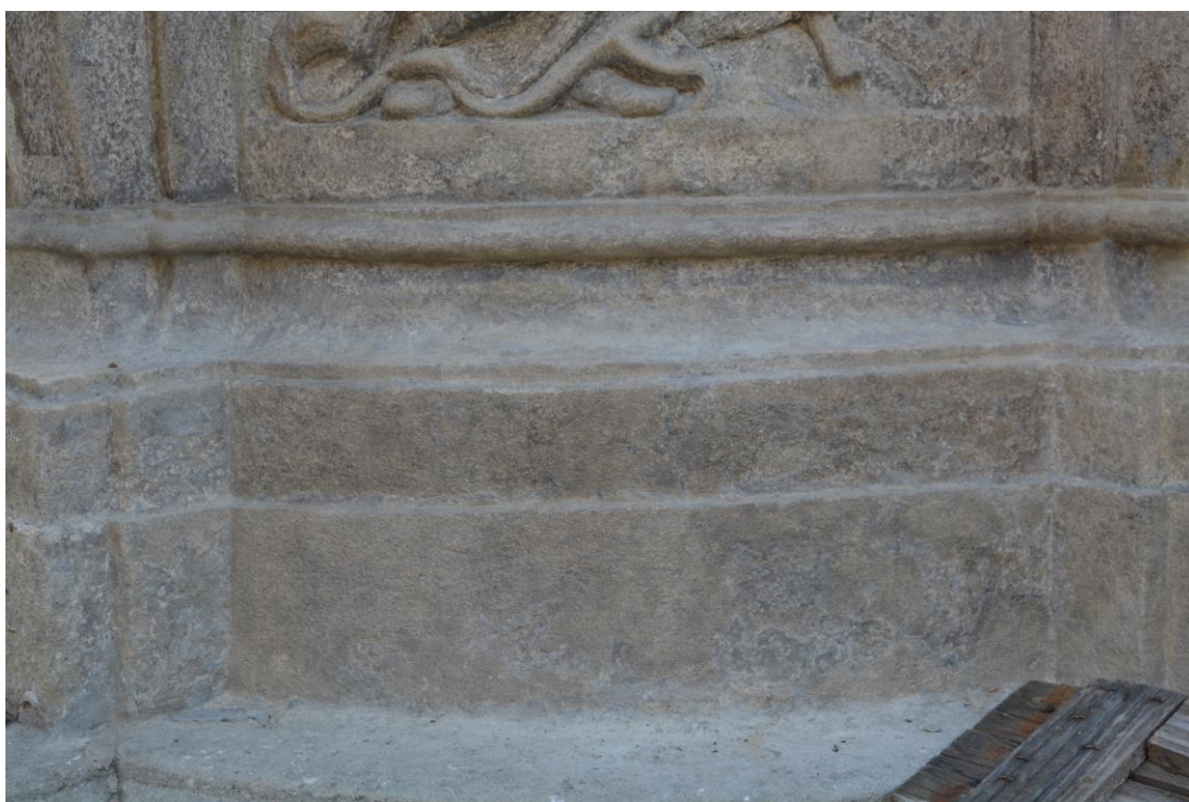
Obr. 34 Stav po restaurování, detail
