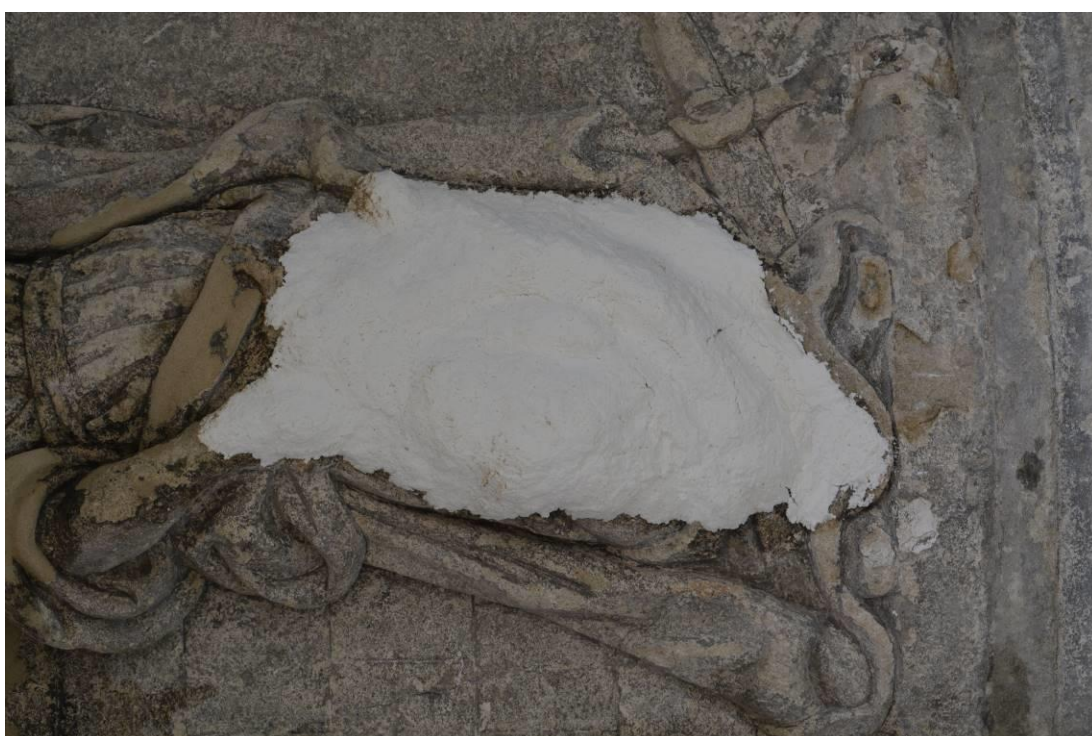
Obr. 24 Lokální odsolovací zábal
