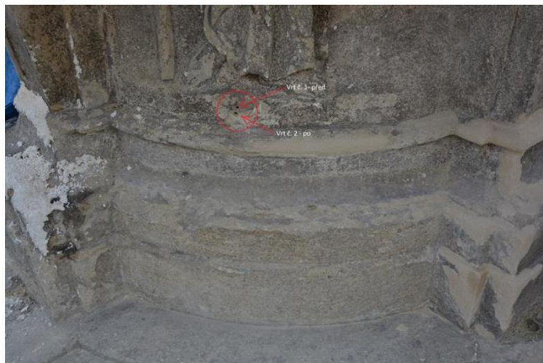
Obr. 66 Lokalizace odběru vzorků vrtné moučky před a po odsolování, reliéf sv. Jakuba Většího.
