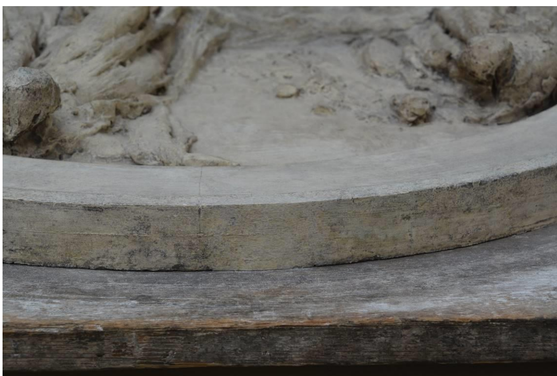
Obr. 67 Stav po restaurování detail
