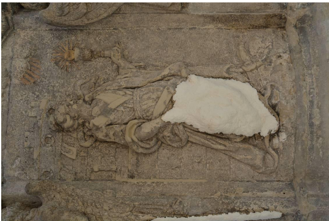
Obr. 23 Lokální odsolovací zábal
