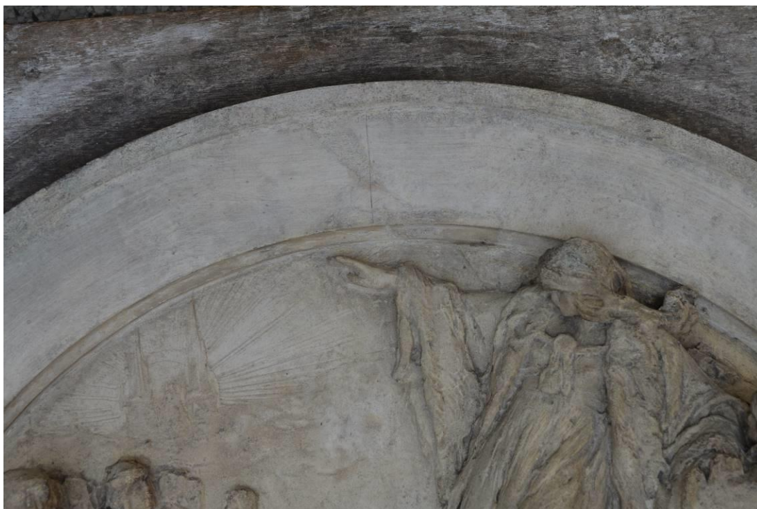
Obr. 66 Stav po restaurování detail
