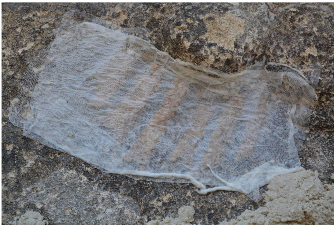
Obr. 21 Zakrytí zlacení při odsolovacím zábalu
