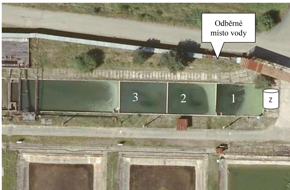
Obr. 3.15 Systém tří průtočných lagun s označeným místem odběru odpadní vody z přívodního potrubí z neutralizační jednotky a umístění zásobníku pro dávkování surovin
