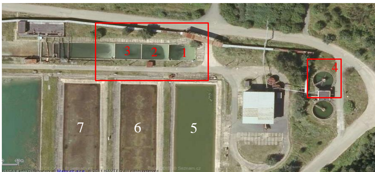
Obr. 3.13 Areál Pustý se systémem tří průtočných lagun využitých pro poloprovozní experimenty (1, 2, 3 – laguny, 4 – kruhová nádrž pro přípravu modelové odpadní vody, 5, 6, 7 – velké laguny určeny pro následný reálný provoz)
