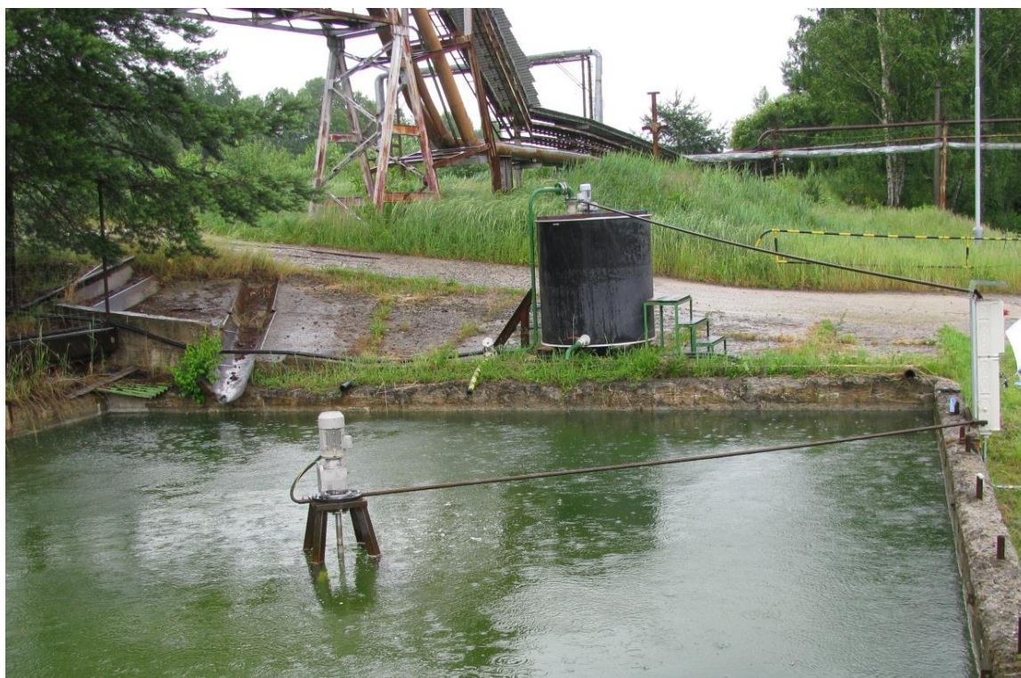
Obr. 3.17 Pohled na první lagunu osazenou míchadlem a zásobník pro dávkování surovin
