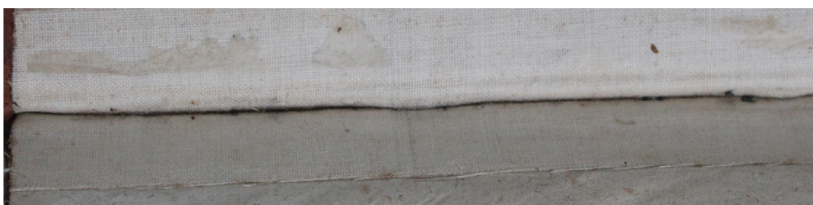
Obr.č. 97 Ukázka vyztužené předsádky plátěným proužkem
