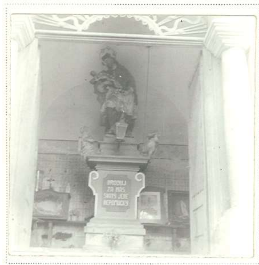
Stav sousoší v roce 1964, detail fotografie z evidenčního listu
