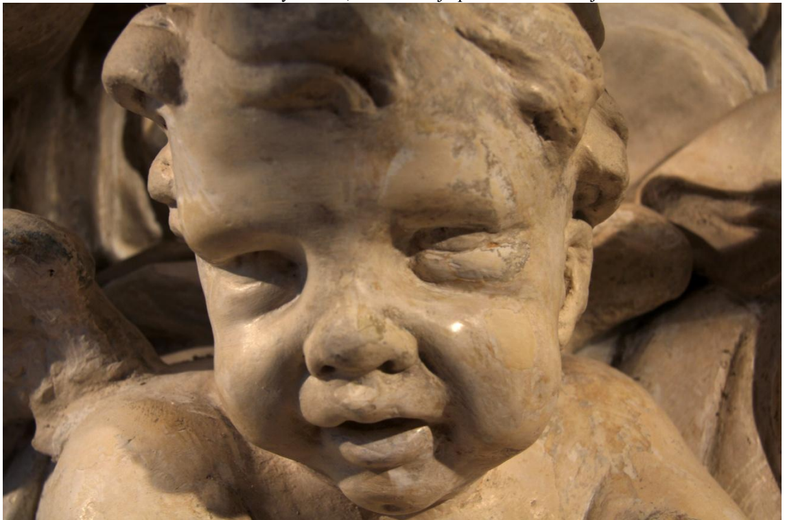
Obr. 150 Detail hlavy andílka, patrná řada nevyhovujících vysprávek po sejmutí olejového nátěru
