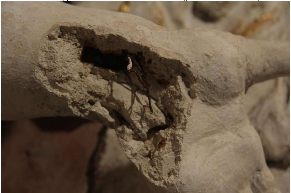
Obr. 171 Kaple sv. Pavla, bazilika Nanebevzetí Panny Marie a sv. Cyrila a Metoděje ve Velehradě, původní vnitřní armatura v ruce Cheruba, doplněná drobnými drátky v dlani (poškození vlivem koroze).
