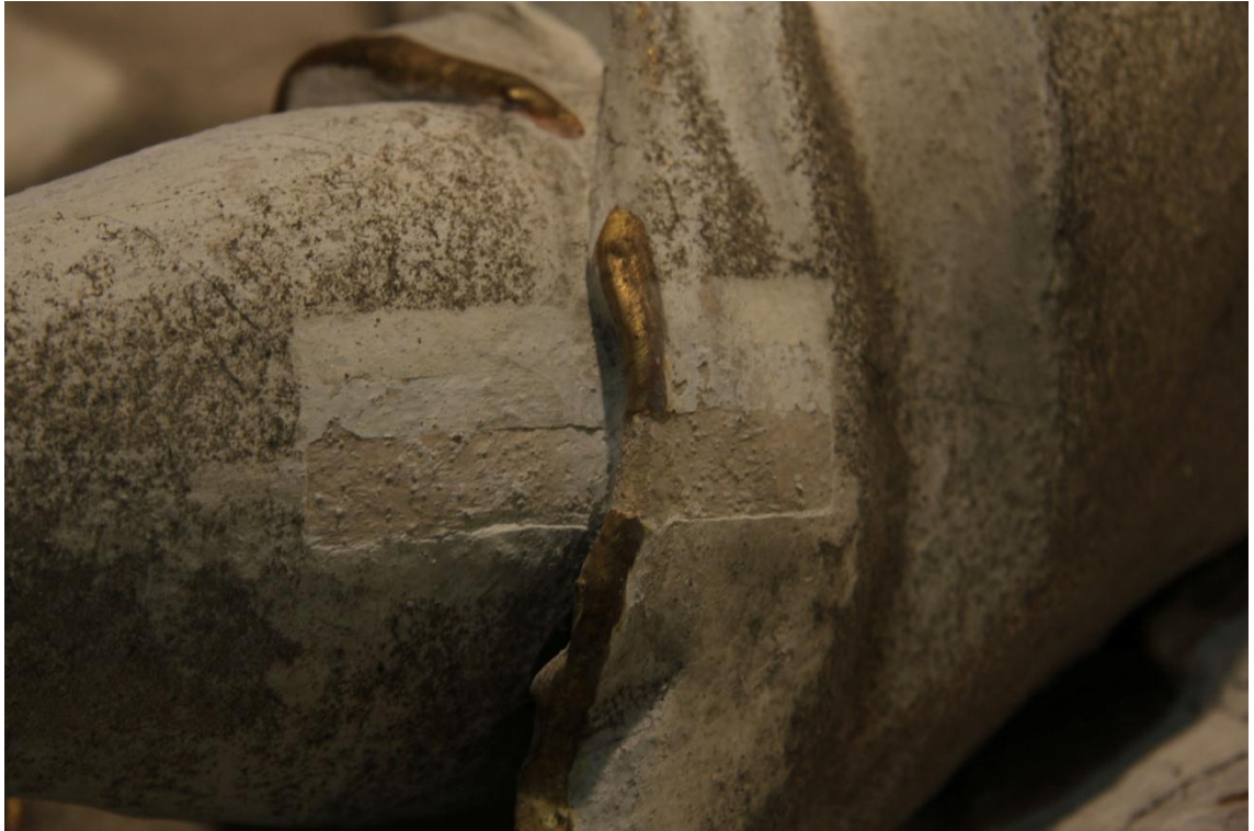
Obr. 166 Kaple sv. Pavla, bazilika Nanebevzetí Panny Marie a sv. Cyrila a Metoděje ve Velehradě, pásová sonda na ruce Cheruba, patrná je povrchová úprava jen vápenným nátěrem přímo na jemné modelační vrstvě.
