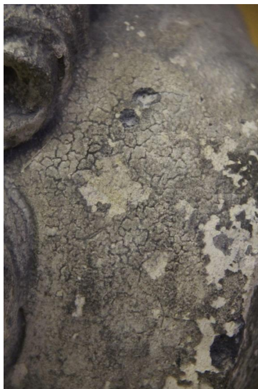
Obr. 111 Detail, stav po zajištění povrchové úpravy a čištění povrchu.
