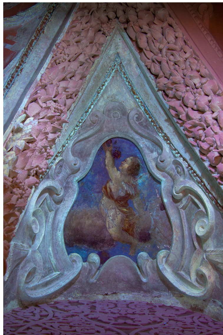
Obr.27: UV fluorescenční fotografie celku. Výraznější žluto-zelenou fluorescenci vykazuje štukový perlovec, druhotné nátěry na štukovém ovoci vykazují fialovou fluorescenci. Stav po čištění, prekonsolidaci a strukturální konsolidaci.
