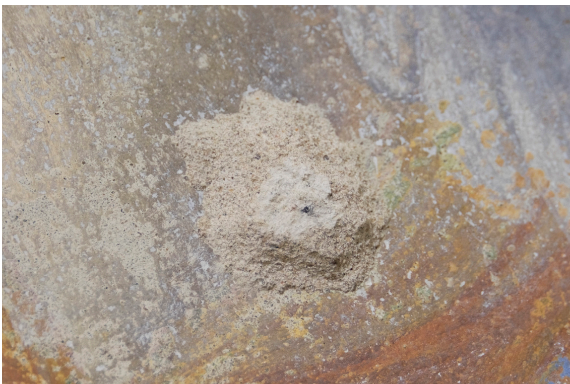
Obr. 24: Poškození: hloubková sonda z r. 2011. Tělo postavy. Stav po odkryvu a čištění.
