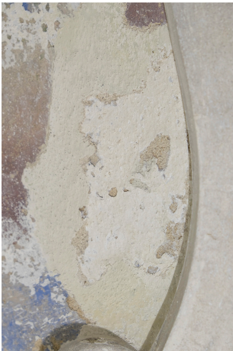
Obr. 11: Druhotné zásahy: defekt v pravém mraku. Druhotná vysprávka. Vrstvy druhotných nátěrů a řídicího tmelu či plněného nátěru. Stav v průběhu odkryvu.
