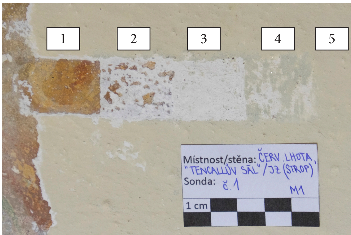
Obr. 28: Sondážní průzkum: sonda č. 1, souvrství v zrcadle s malbou. Popis jednotlivých vrstev viz [Tab. 01, s. 36]
