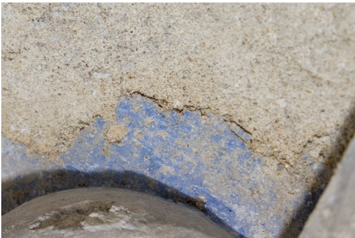
Obr. 23: Detail poškození: ztráta adheze původní barevné a omítkové vrstvy. Obloha v pravé dolní části výjevu. Stav po odkryvu a čištění.
