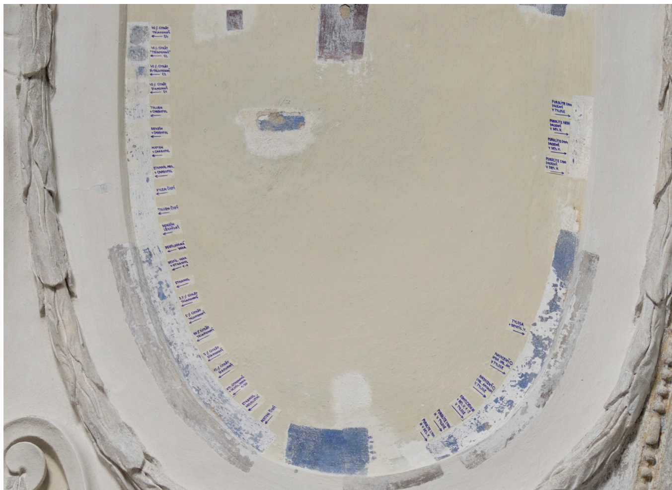
Obr.32: Zkoušky chemického odstraňování druhotných vápenných nátěrů. Větší malované zrcadlo vlevo.
