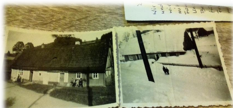
Obr. 5, respondentův dům (zdroj: respondent PR)
