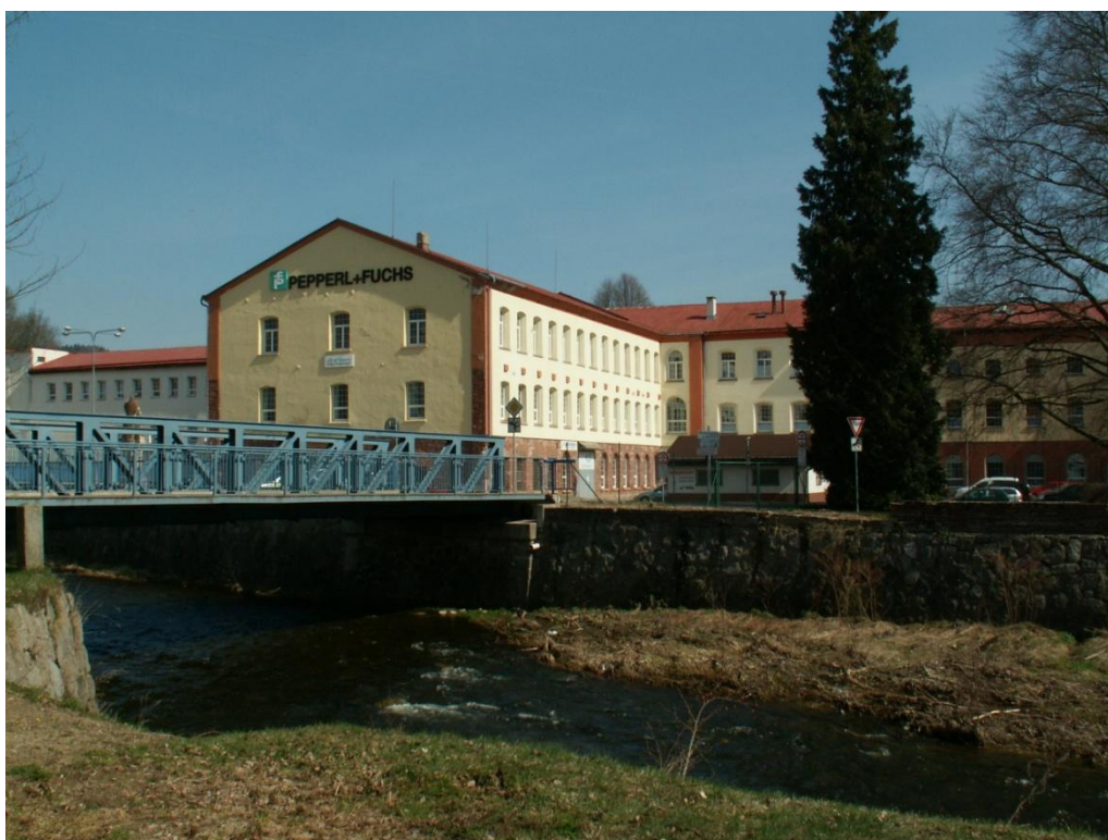
Areál bývalé textilní továrny v Horním Starém Městě (Foto autor)
