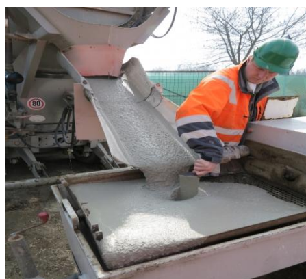
Obrázek 40: Čerpání směsi z autodomíhávače
