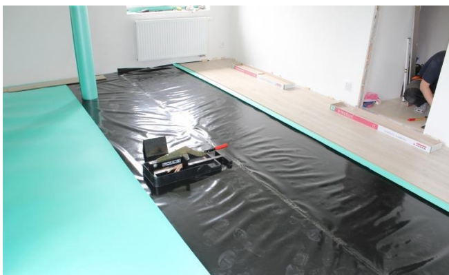
Obrázek 36: Pokládka laminátové podlahy
