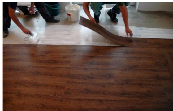
Obrázek 22: Lepení vinylové podlahy
