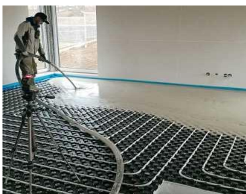
Obrázek 39: Aplikace anhydritové směsi
