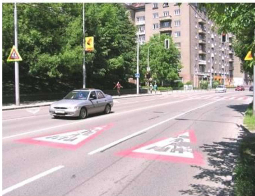
Obrázek 31 Použití vodorovného dopravního značení V15 pro zvýraznění přechodu pro chodce
