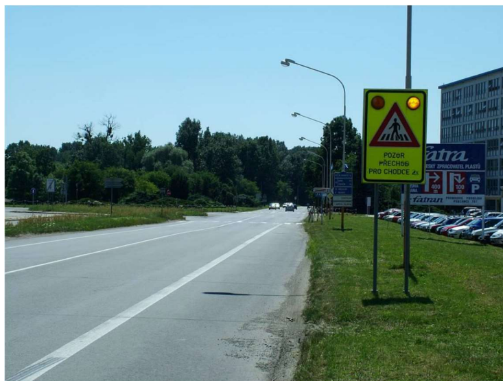
Obrázek 30 Příklad nevhodné kombinace zvýrazňujících prvků svislého dopravního značení
