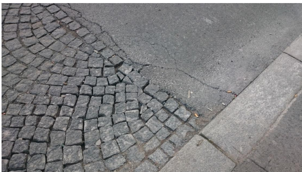
Obr. 13 Uvolněné dlažební kostky v zastávce „Tylova“
