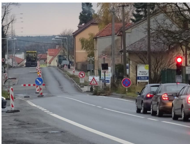
Obr. 2 Částečná uzavírka PK řízená světelným signalizačním zařízením Zdroj: (foto autor)
