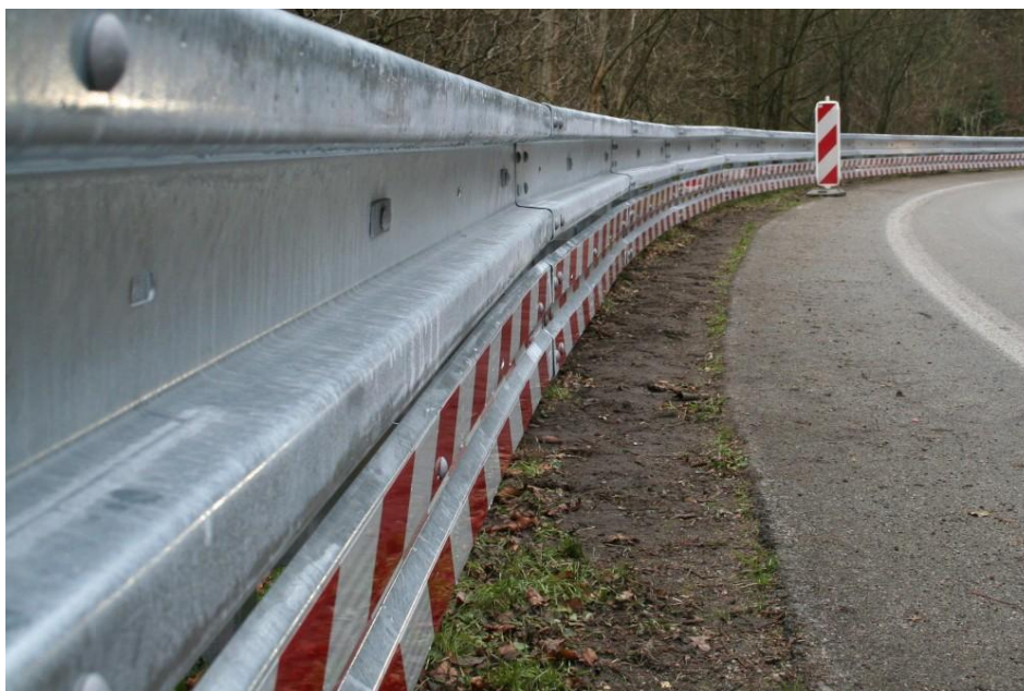
Obrázek 10: Svodidlo JSNH4/H2 se spodní pásnicí
