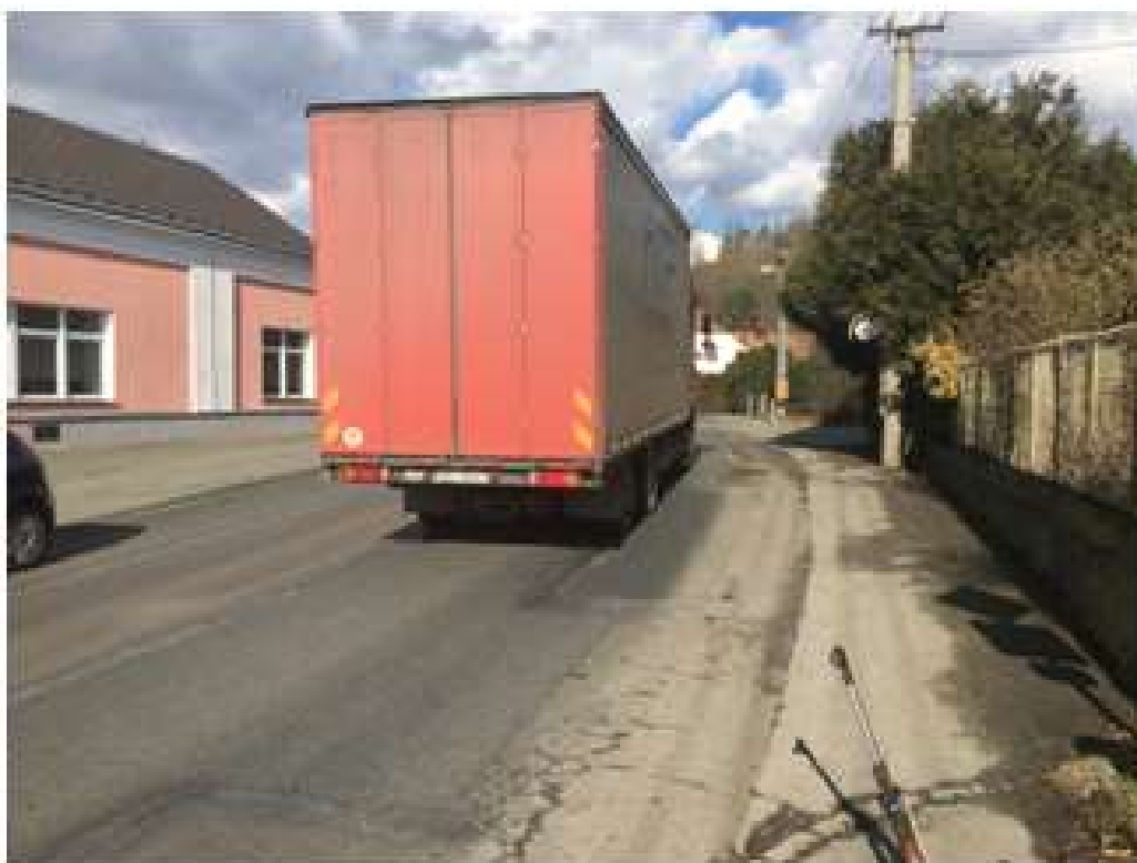
Obrázek 20: Nevhodně řešená autobusová zastávka v obci Podhořany.
