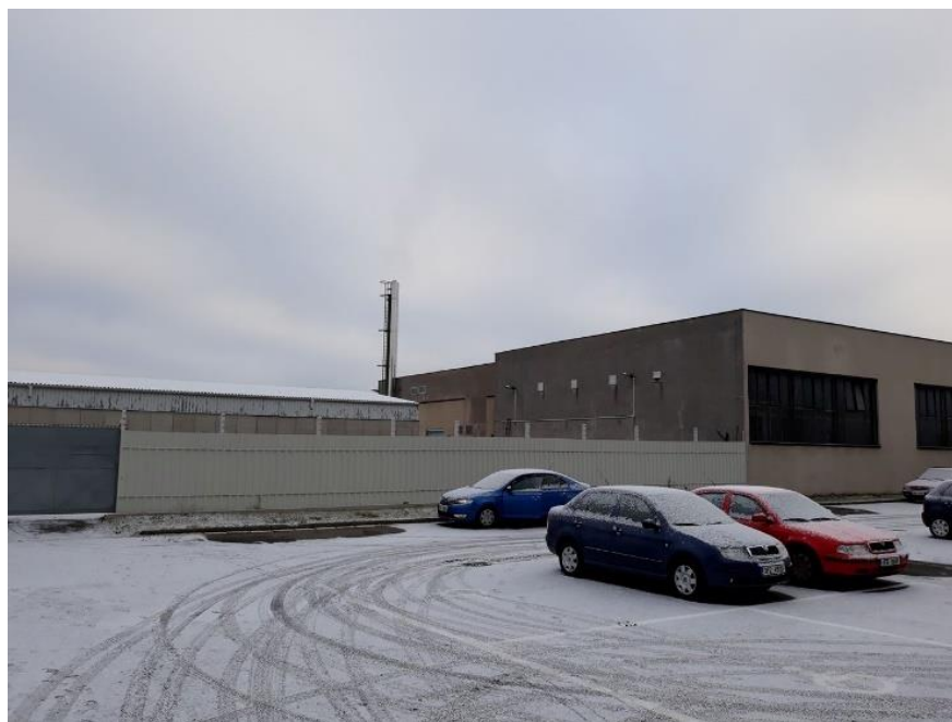
Obrázek 6 Hala pro skladování materiálu pro zimní údržbu
