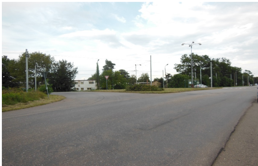
Obr.8 Větev pro odbočení ze silnice I/36 na silnici III/32225 Zdroj: (autorka)
