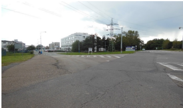
Obr.29 Špatně viditelné stávající vodorovné dopravní značení Zdroj: (autorka)
