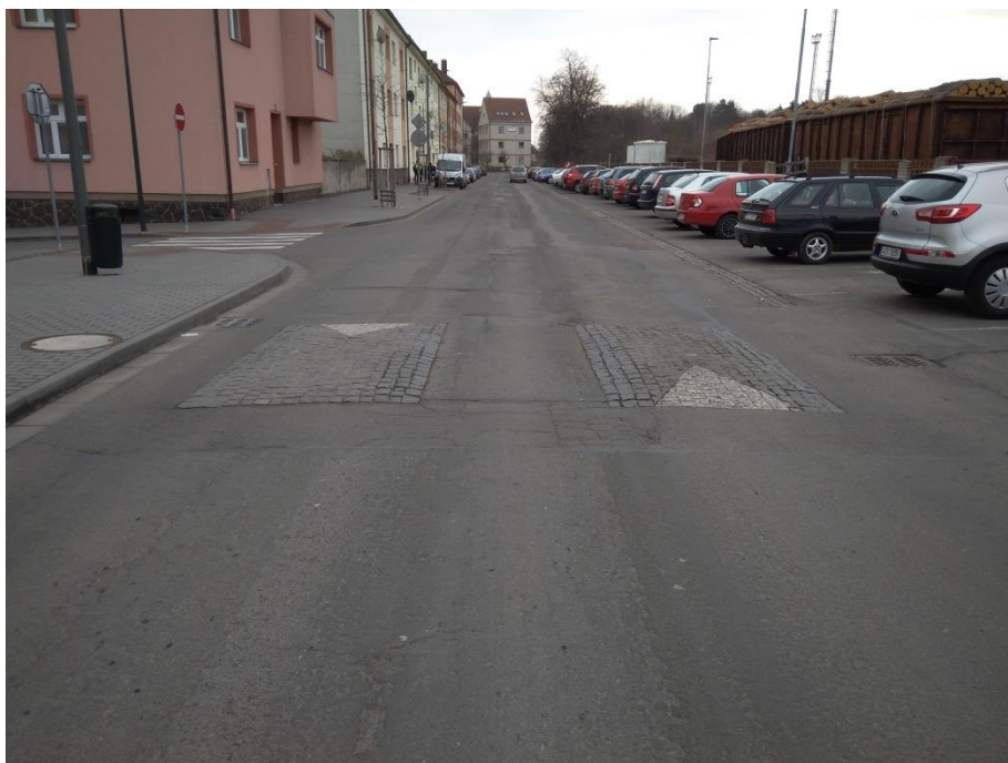
Obrázek 3 Lichoběžníkový tvar zpomalovacího polštáře
