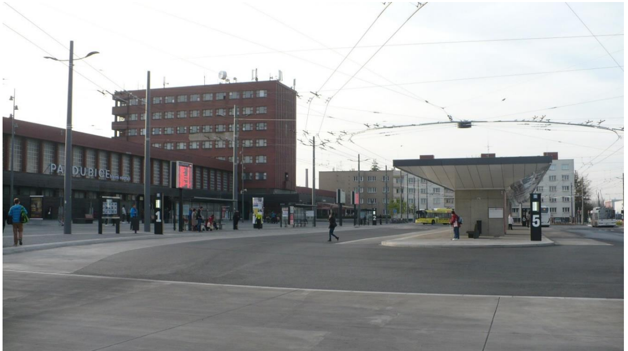
Obr. 2 Pohled na Terminál A - intermodální uzel před pardubickým hlavním nádražím
