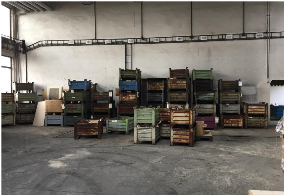
Obrázek 8 Stávající stav uvnitř skladu č. 2
