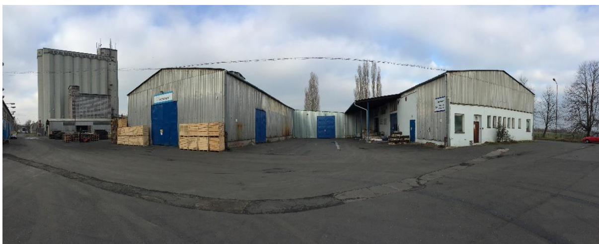
Obrázek 5 Venkovní pohled na sklad č.1
