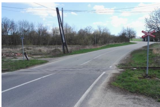
Obr. 1 Železniční přejezd s výstražným křížem A 32a
