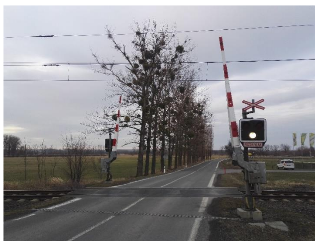
Obr. 3 Železniční přejezd s PZZ a závorami s pozitivním signálem
