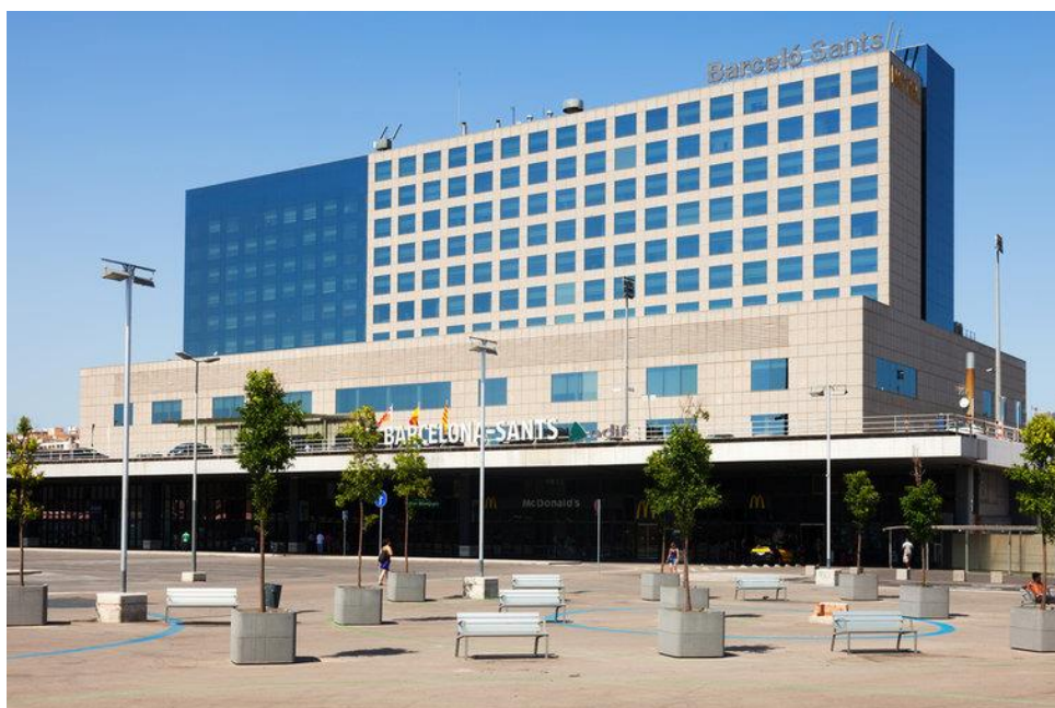
Obrázek 12 Železniční stanice Barcelona Sants v Barceloně
