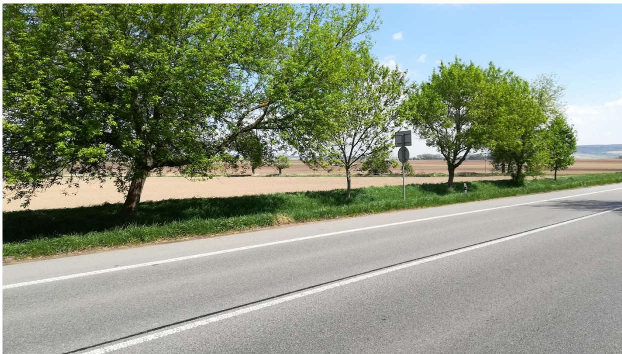
Foto 21 – Pohled na místo, kde se varianta II napojí na stávající silnici I/11 (křižovatka K. 2.4)
