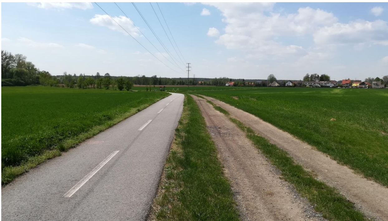
Foto 6 – Pohled místo, kde vznikne podjezd cyklostezky pod navrhovanou silnicí I/11
