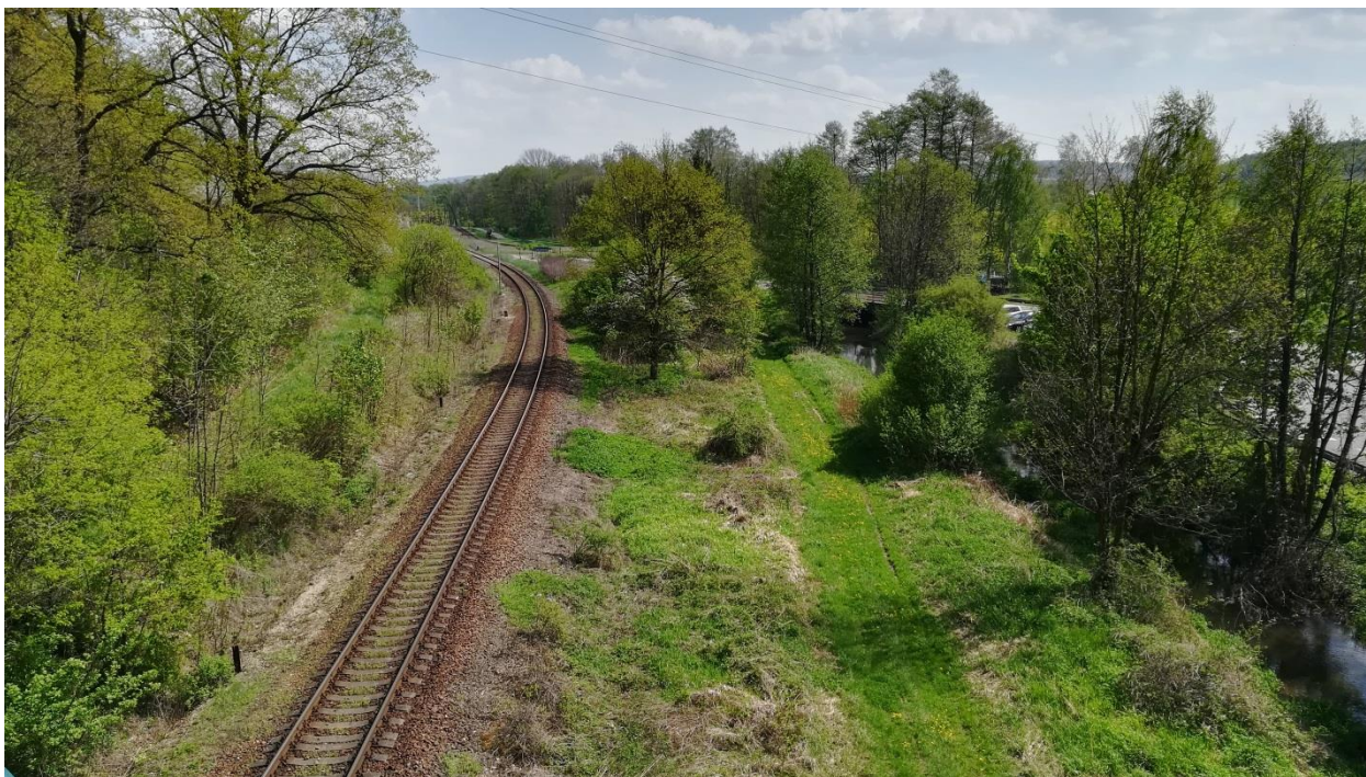
Foto 8 – Pohled na železniční trať 513 A (Letohrad – Týniště nad Orlicí)
