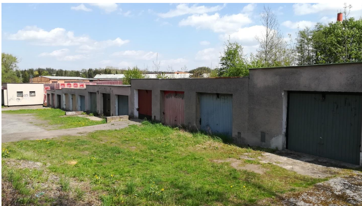
Foto 18 – Pohled na garáže určené k demolici (pouze u varianty I)
