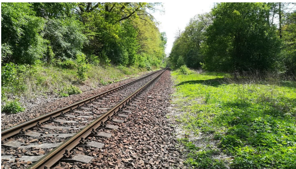
Foto 12 – Pohled na místo, kde je navržen sedmipolový most přes cyklostezku, železniční trať 513 A a slepé rameno řeky
