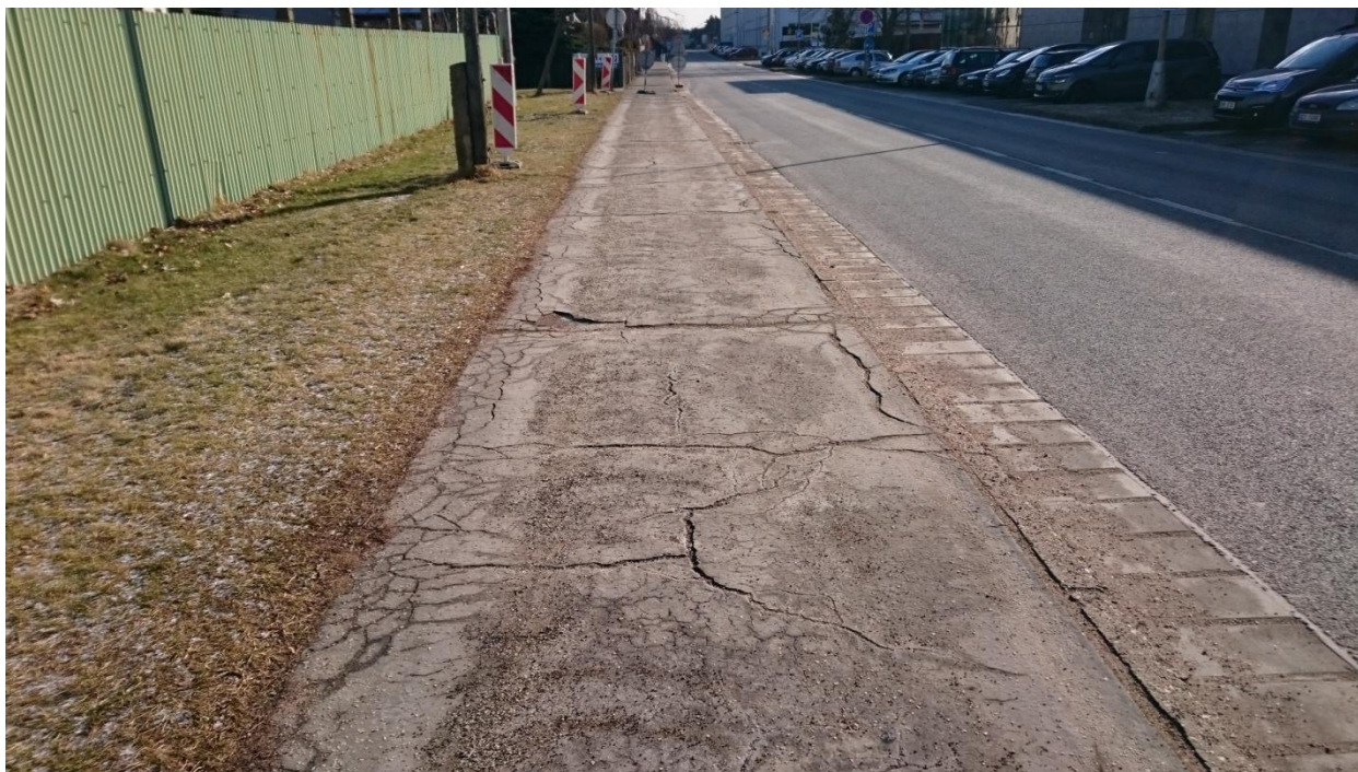
Fotografie č. 3 – Stávající chodník z litého asfaltu – před opravou. Navrhovaný stav – Posun oplocení areálu, změna vedení společné stezky pro chodce a cyklisty, zelený pás je pro zvýšení bezpečnosti nově navržen mezi společnou stezkou a vozovkou.
