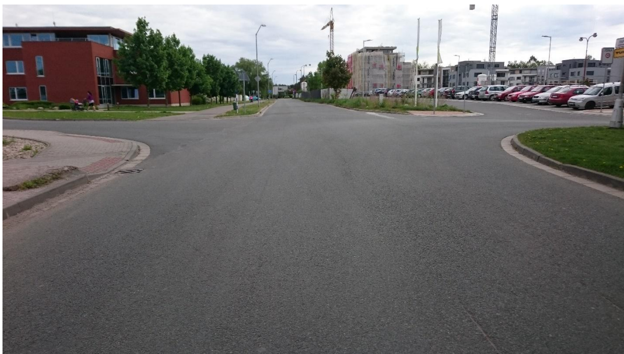
Fotografie č. 14 – Konec stavebních úprav – současný stav průsečné křižovatky, v dálce po levé straně společná stezka pro pěší a cyklisty. Navrhovaný stav – Nová okružní křižovatka – křížení ulic Na Brně a Průběžná.
