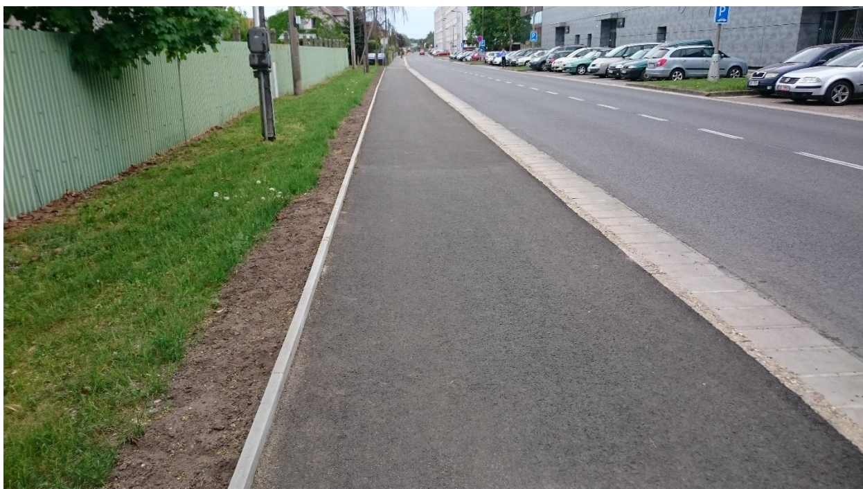
Fotografie č. 4 – Opravený chodník z asfaltobetonu ACO11 s přirozenou vodící linií - oprava duben 2018.
